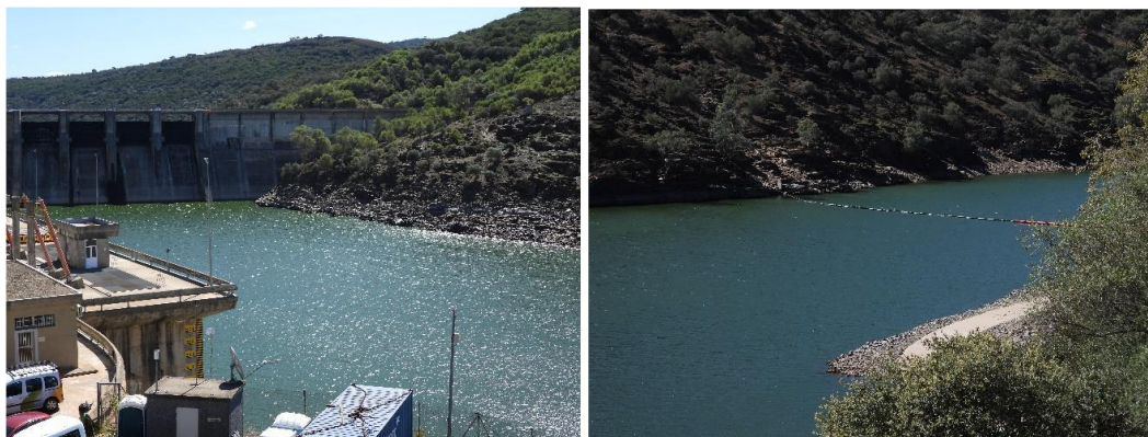
Foto 11 y 12. Río Tajo. Zona bajo la Presa. Río de color verde oscuro intenso. Se observa la Barrera colocada para el control de Azolla.
