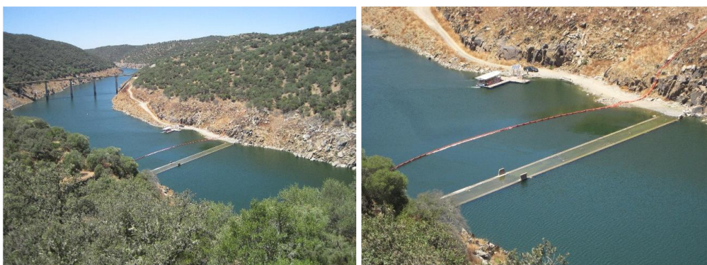
Fotos 8 y 9. Zona Puente de Serradilla donde se observa agua con tonalidad verdosa.
