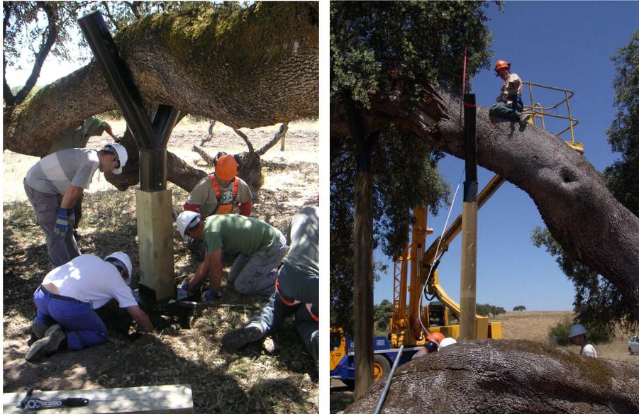
Fig. 3 Colocación de las orquillas y los 20 pilares de madera
