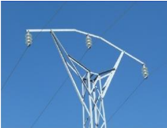
La línea presenta dos apoyos metálicos en bóveda con tres aisladores de vidrio pequeños y los cables están señalizados con bolas blancas.
