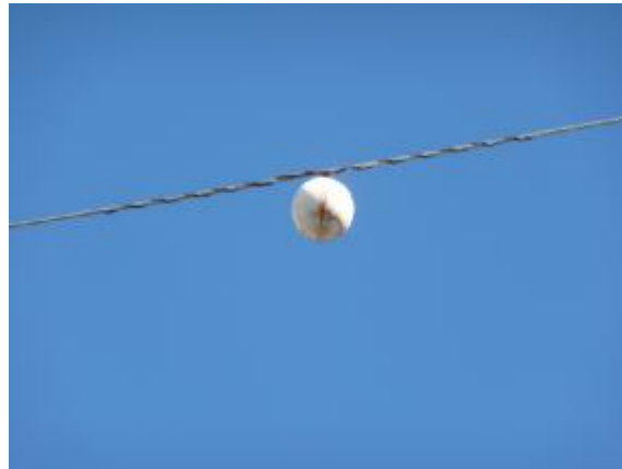
La línea presenta dos apoyos metálicos en bóveda con tres aisladores de vidrio pequeños y los cables están señalizados con bolas blancas.
