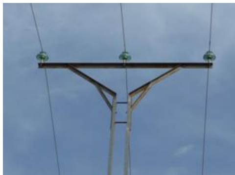
Las crucetas metálicas en 0 de aisladores rígidos fueron sustituidas por crucetas en bóveda con tres aisladores suspendidos. Se han aislado los elementos conductores centrales con fundas protectoras de Raychem.
