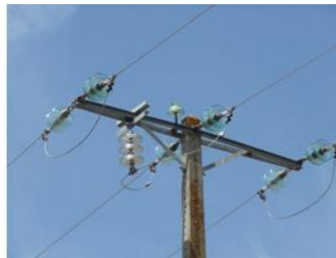
Apojo 5141 aparentemente rectificado. El apojo 5139 es igual pero con aislador central rígido con puente
