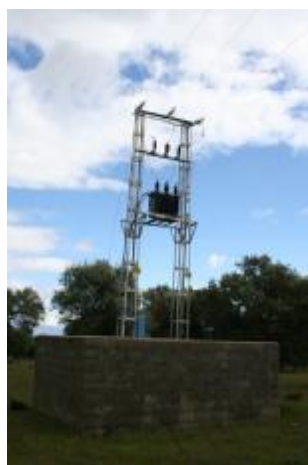
Imagen del tipo de apoyo que conforma la línea y transformador final
