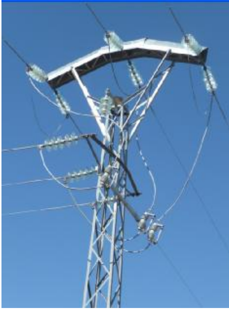
Apoyo derivación a Aguzaderas y apoyo transformador final situado junto a la casa, ya con las medidas correctoras efectuadas.
