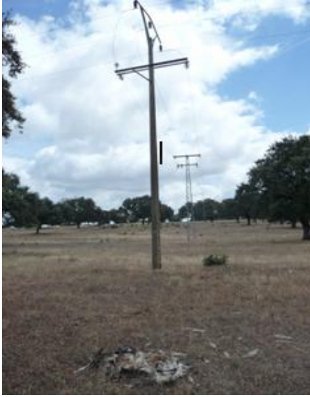
Apoyo 2187 derivación a tresbolillo y buitre electrocutado.
