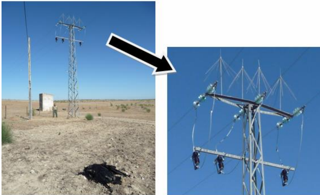
Detalle del apoyo responsable de la electrocución de un cuervo, junto a las casa Los Homos, penúltimo apoyo de la línea.
