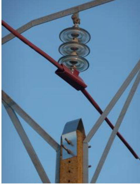
Fotografías de las modificaciones efectuadas y detalle del recubrimiento de la grapa y del disuasor de posada.
