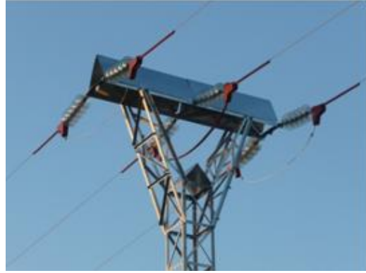
Fotografías de las modificaciones efectuadas y detalle del recubrimiento de la grapa y del disuasor de posada.
