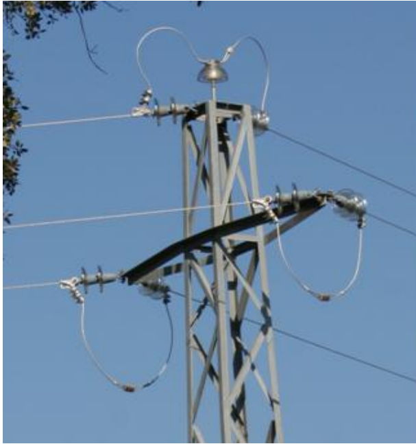
Apoyo metálico en amarre en uno, con puente flojo superior al aislador central rígido, situado en la orilla del Tiétar cerca del transformador fin de línea (foto derecha).
