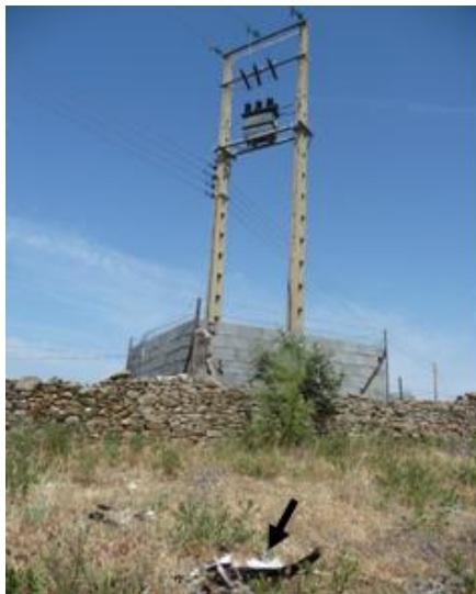
Cadáver de cigüeña blanca y apoyo transformador responsable de su electrocución.
