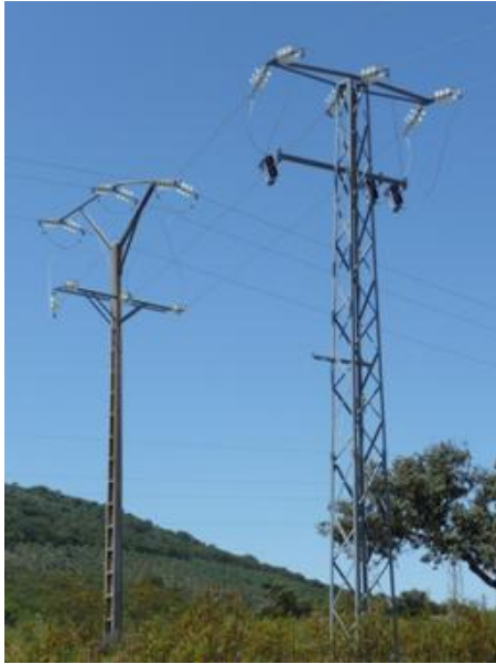
Apoyo derivación a casa Agapita y apoyo en amarre, que aparece intercalado entre los de tipo bóveda.
