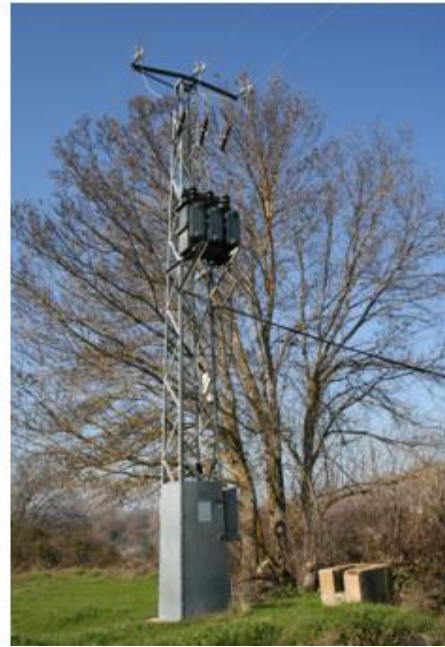
Apoyo metálico en amarre en uno, con puente flojo superior al aislador central rígido, situado en la orilla del Tiétar cerca del transformador fin de línea (foto derecha).
