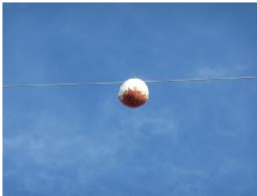
Como se aprecia en la imagen las bolas anticollisión se encuentran muy deterioradas y sólo están presentes en el vuelo sobre el arroyo Getrero. Foto derecha restos muy antiguos de águila real electrocutada bajo apoyo de bóveda.
