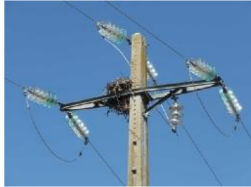
La línea está conformada por apoyos de hormigón con cruceta tipo bóveda con dos aisladores suspendidos. Imagen derecha de un apoyo en amarre en 1 modificado, ocupado por una pareja de cuervos.
