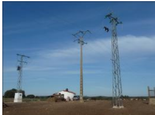
Imágenes de los distintos tipos de apoyo presentes en la línea y de la derivación de la línea principal.
