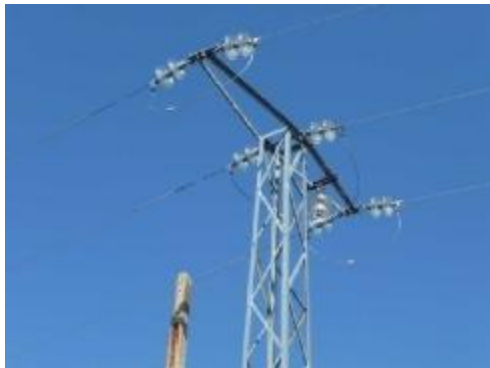
Apoyo metal amarre junto a carretera coordenadas 662899 4381306 y Apoyo derivación a Clavería
