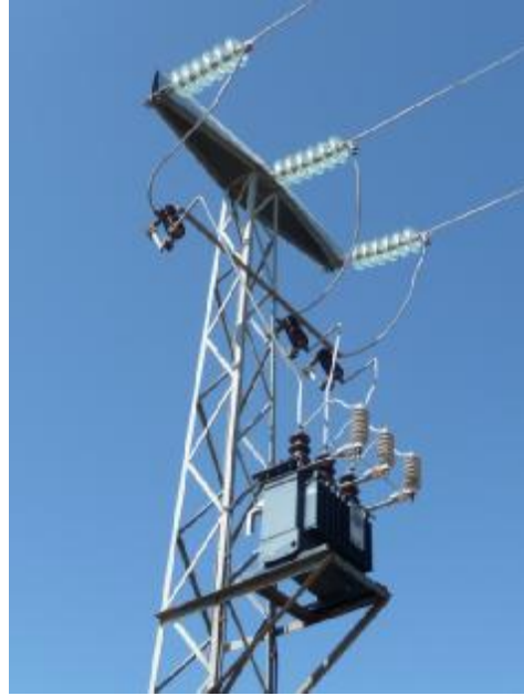
Apoyo derivación a Aguzaderas y apoyo transformador final situado junto a la casa, ya con las medidas correctoras efectuadas.
