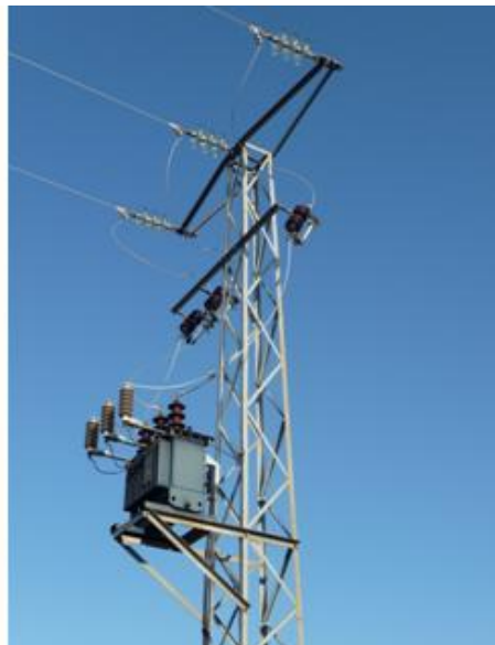
De izda. a dcha. y de arriba abajo, apoyo de inicio derivación, apoyo transformador final, y los dos únicos apoyos en amarre presentes en la línea.
