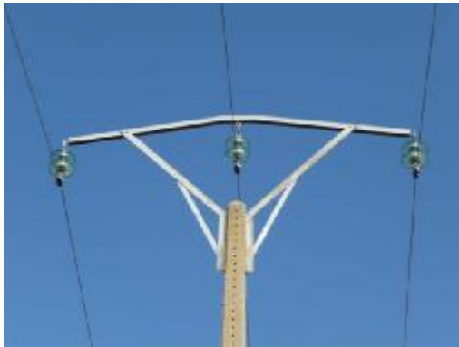
La línea está conformada por apoyos de hormigón con cruceta tipo bóveda con dos aisladores suspendidos. Imagen derecha de un apoyo en amarre en 1 modificado, ocupado por una pareja de cuervos.
