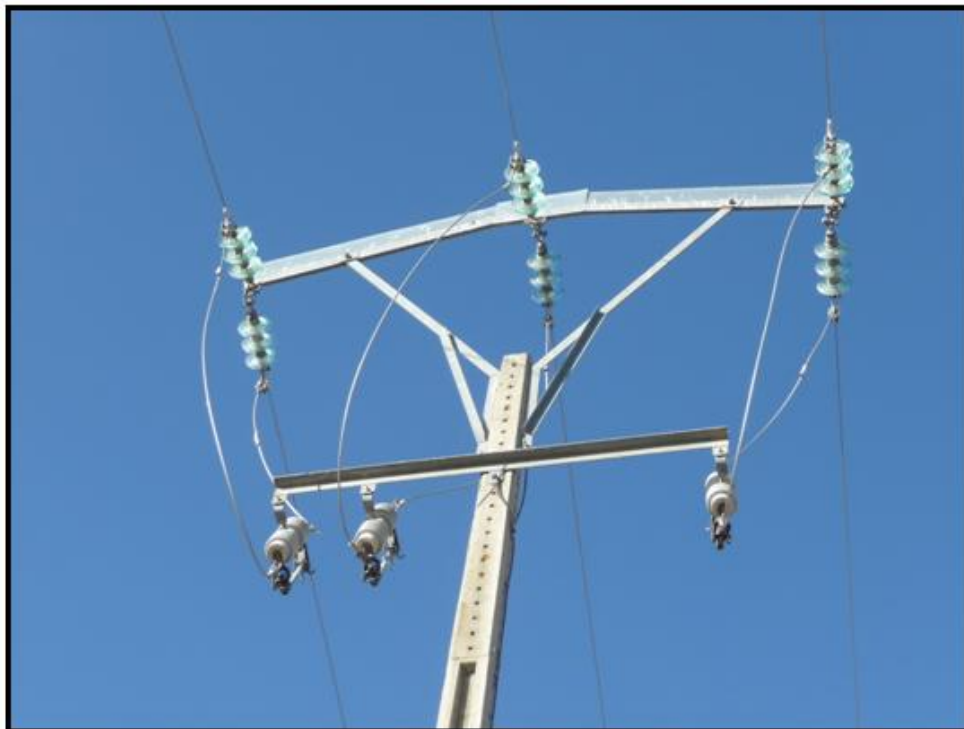
Apoyo responsable de la electrocución del Águila imperial en la finca El Parral
