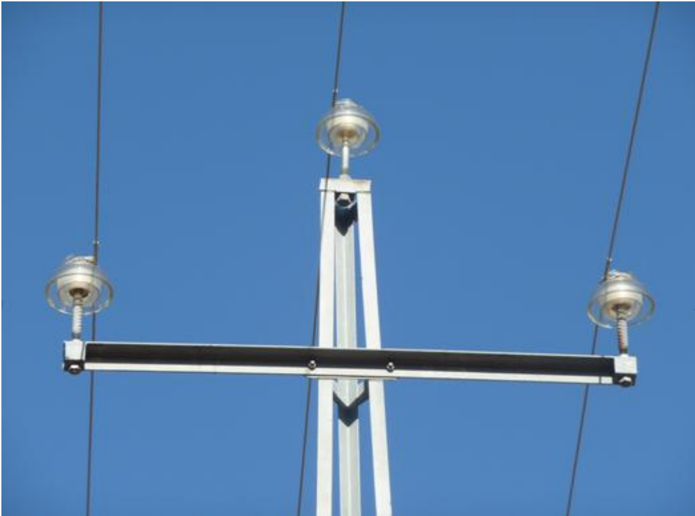
Apoyo N° 23 (coordenadas 30S0250571 4417164) responsable de la electrocución de un joven del año de Milano negro encontrado el 28 de Julio (foto inferior)
