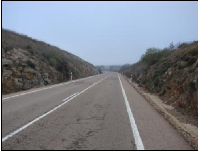
Tramo peligroso del punto 6
