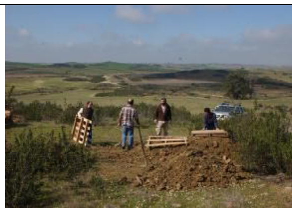
Estrutura de reprodução e abrigo (morouço) em construção
