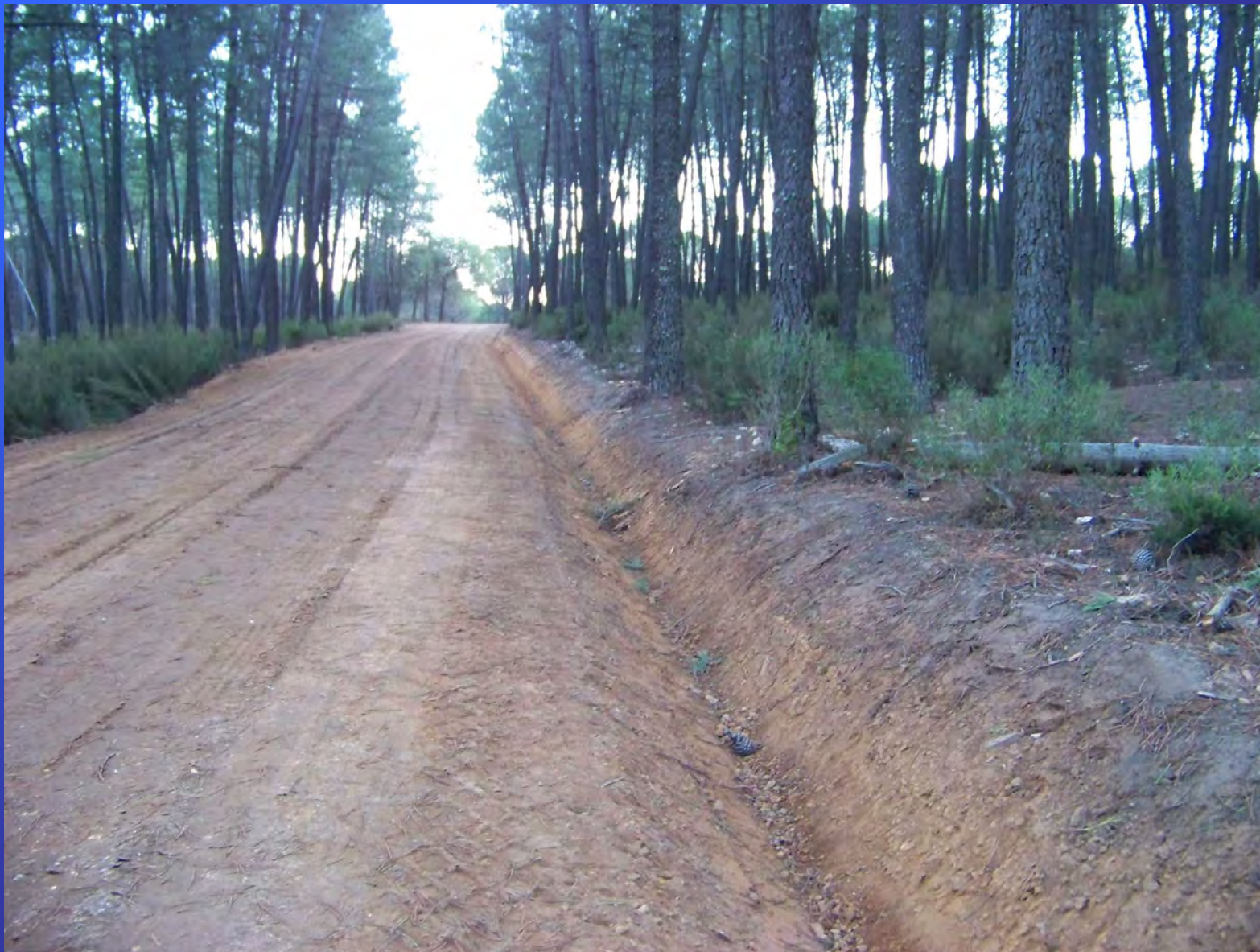
Detalle de las cunetas
