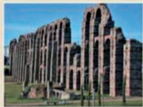
ACUEDUCTO "LOS MILAGROS"
