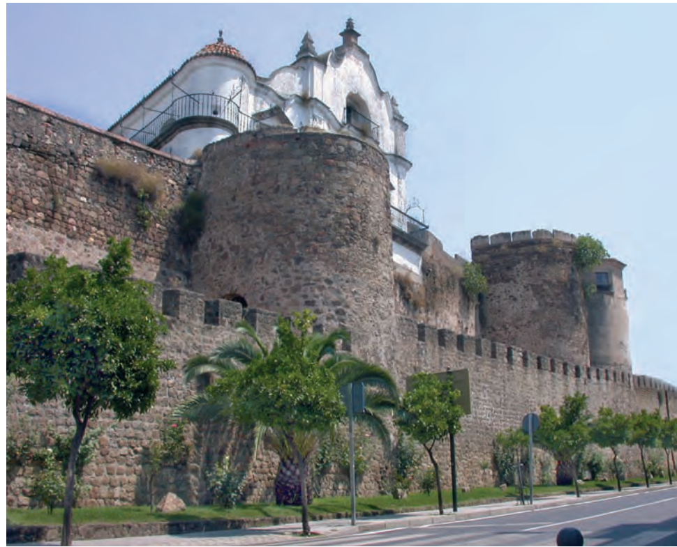
Muralla de Plasencia.
