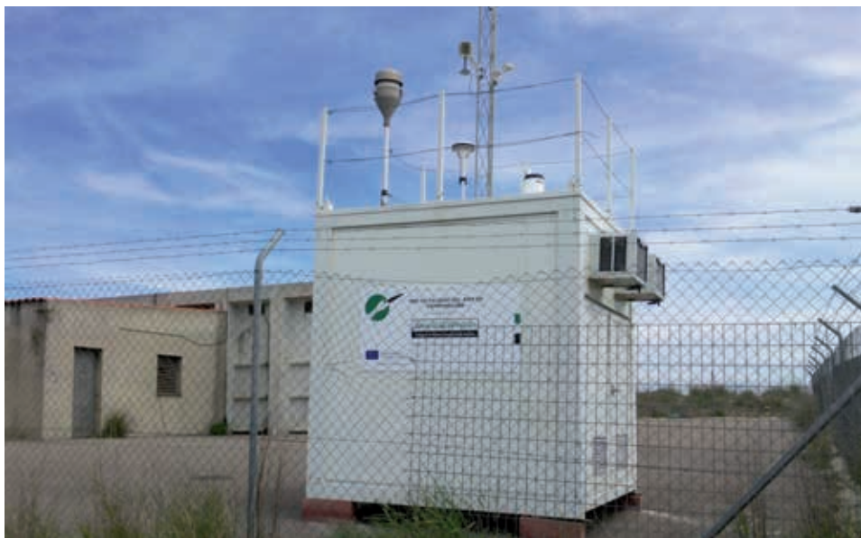
Figura 11. Cabina de calidad del aire de la red REPICA ubicada en Zafrá en polígono industrial.
