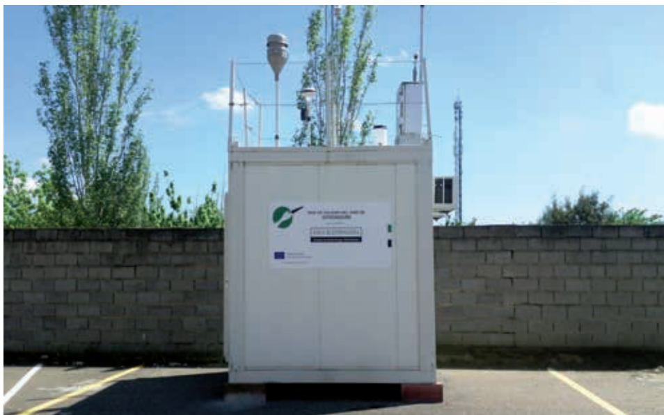
Figura 9. Cabina de calidad del aire de la red REPICA instalada en Mérida en el Centro Universitario.
