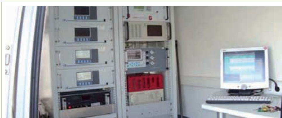
Figura 14. Interior de una estación móvil, se observan los analizadores, equipos y ordenador.
