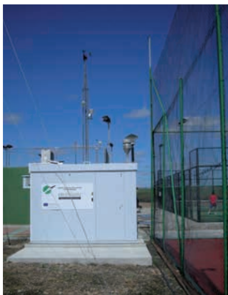
Figura 7. Cabina de calidad del aire de la red REPICA ubicada en Badajoz en el Campus Universitario.
