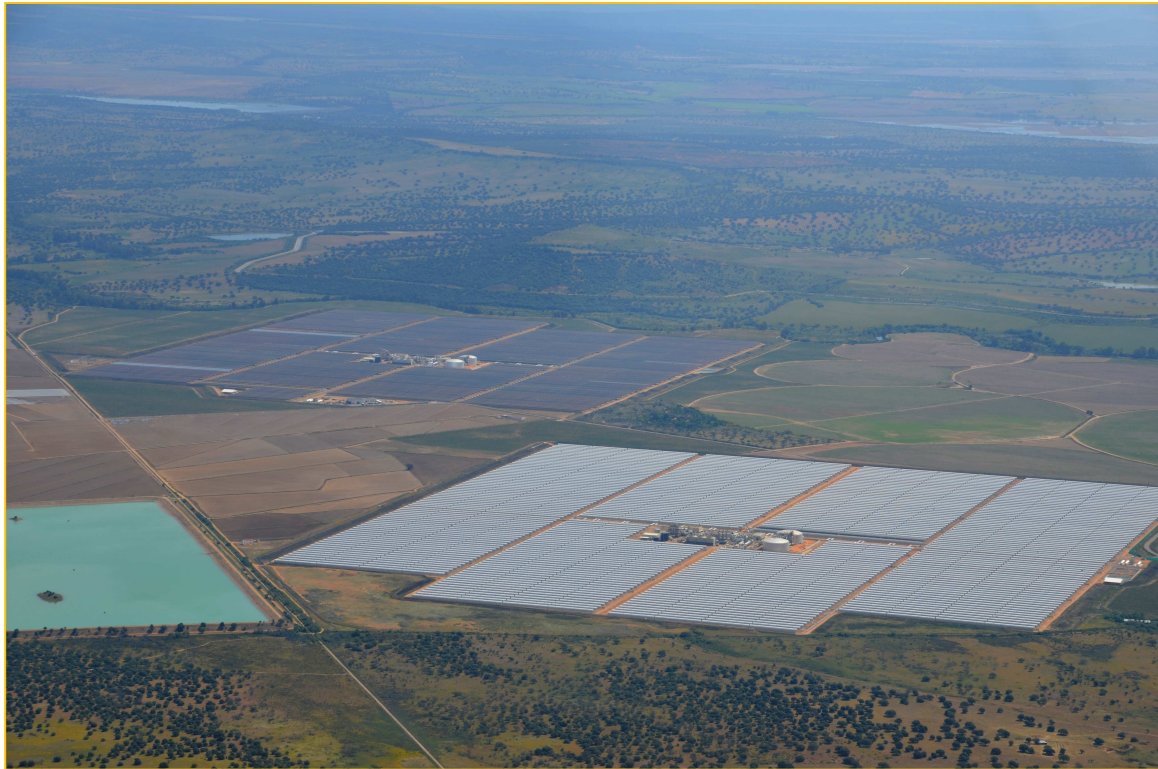
Fotografía: Imagen aérea huerta solar en Extremadura
