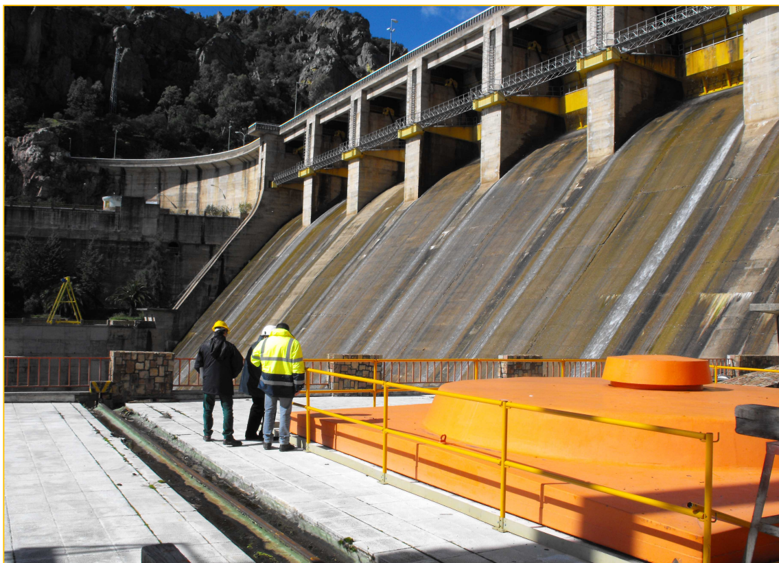
Fotografía: Inspección a central hidroeléctrica
