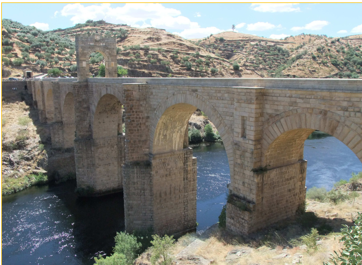
Fotografía: Imagen Puente de Alcántara
