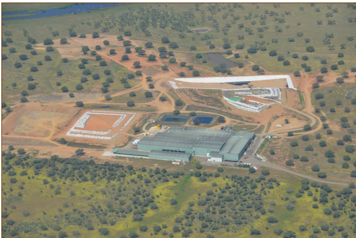
Fotografía: Imagen aérea de Ecoparque de residuos en la provincia de Cáceres
