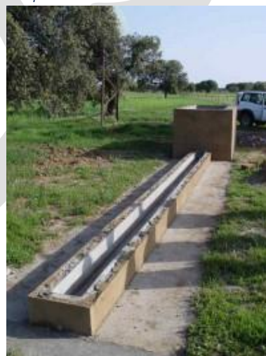
Imágenes 5 y 6. Construcción de pozo de sondeo asociado a abrevaderos para evitar uso excesivo de humedales 4
