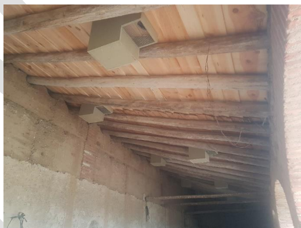
Imágenes 29, 30, 31 y 32. Sustitución de vigas y cambio de tejas con instalación de nidos artificiales 17
