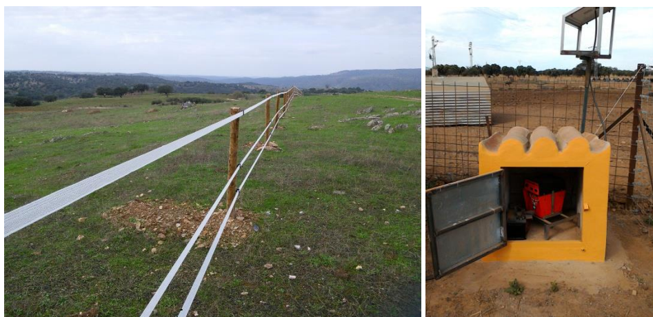
Imágenes 58 y 59. Sustitución de alambrada de espinos por instalación de pastor eléctrico + pastor eléctrico + caseta pastor eléctrico 31
