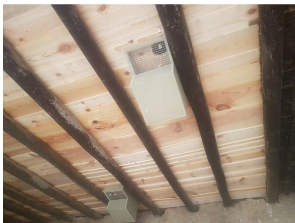
Imágenes 29, 30, 31 y 32. Sustitución de vigas y cambio de tejas con instalación de nidos artificiales 17
