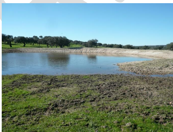
Imágenes 52 y 53. Construcción de charcas 28
