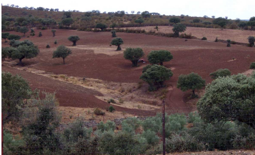
Labores de preparación del terreno
