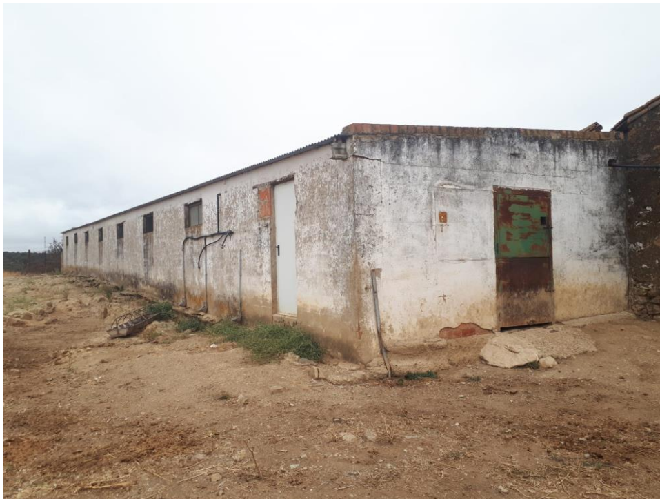
Foto 1: Alzado principal de acceso a la nave de secuestro y lazareto.
