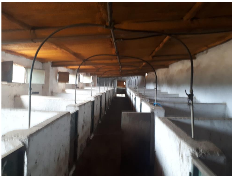
Foto 3: Interior de la nave de secuestro.
