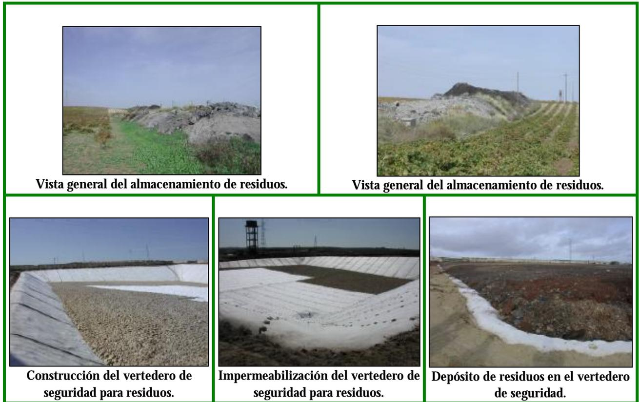
Figura 4.5. Etapas del proceso de rehabilitación de suelos contaminados en Villafranca de los Barros (Badajoz).
