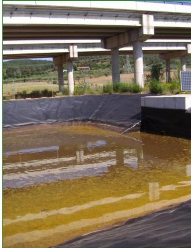
Figura 4.1. Balsa de retención de vertido de hidrocarburos.
