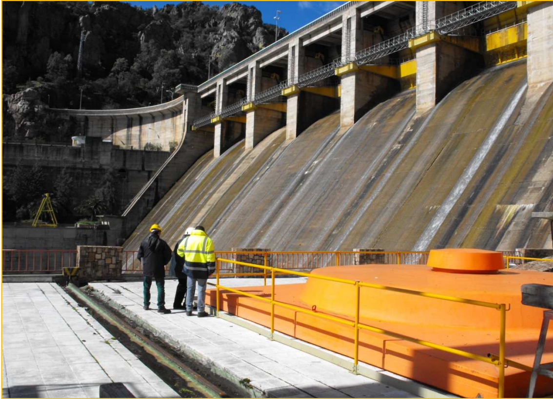
Fotografía: Inspección a central hidroeléctrica
