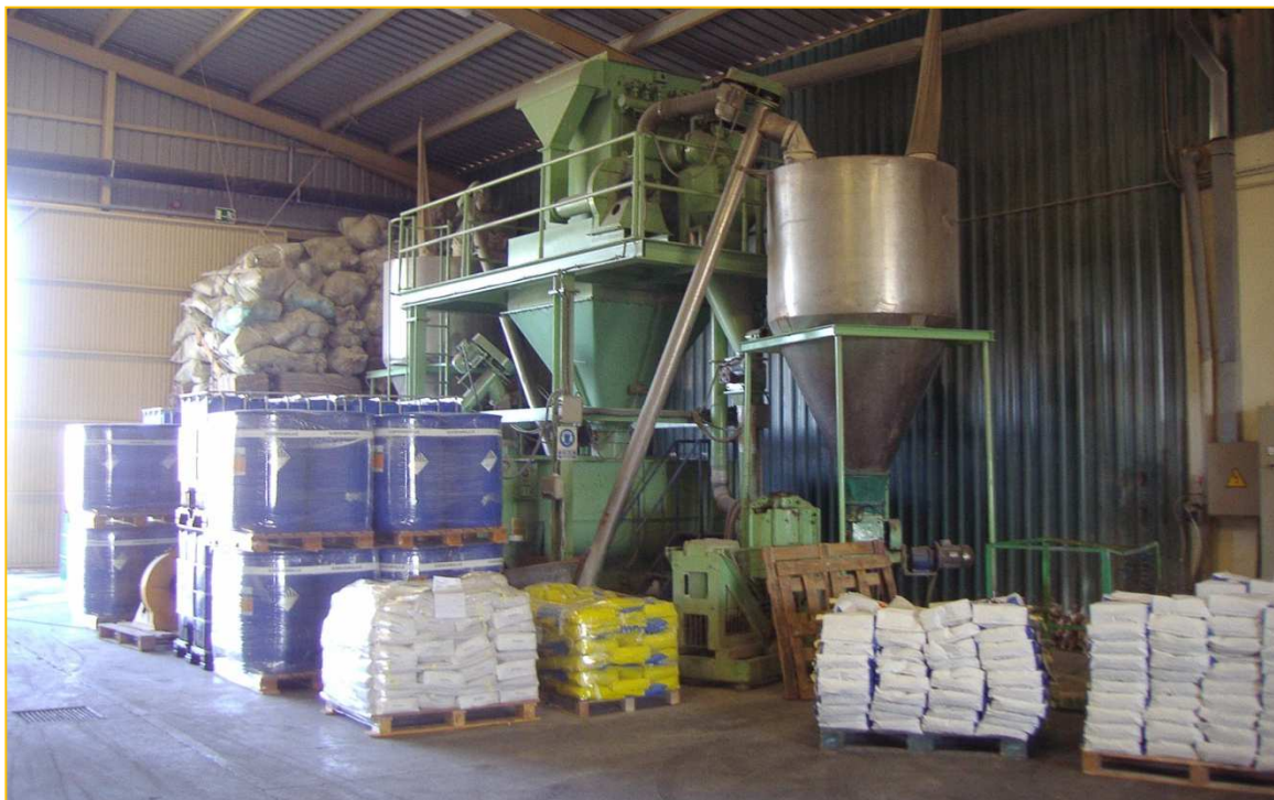
Fotografía: Imagen de Instalación industrial en Extremadura
