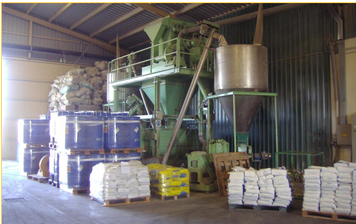
Fotografía: Imagen de Instalación industrial en Extremadura
