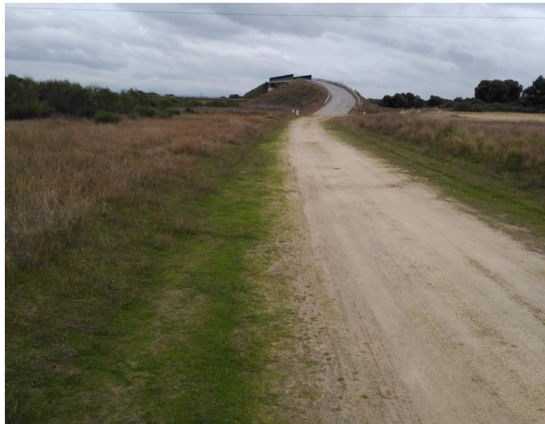
Foto 7: Recorrido actual de la Colada del Arroyo de Santa Maria y Camino de la Fuente de la Rosa, al final se observa el paso superior mediante el que se resolvió el cruce con la L.A.V. Madrid Extremadura.
