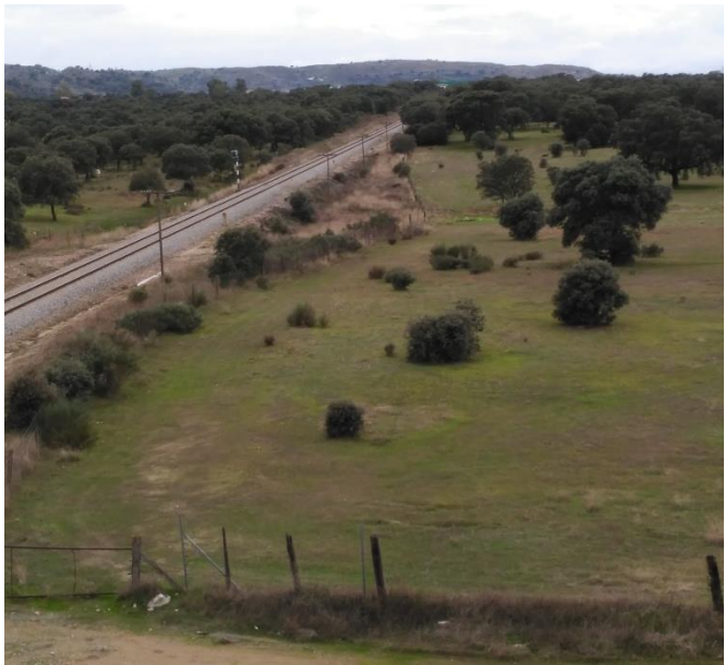
Foto 3: Vista general del emplazamiento de la plataforma logística, como se observa la parte inicial corresponde a un pastizal con pies aislados de encina mientras que en el tramo final corresponde a una dehesa.
