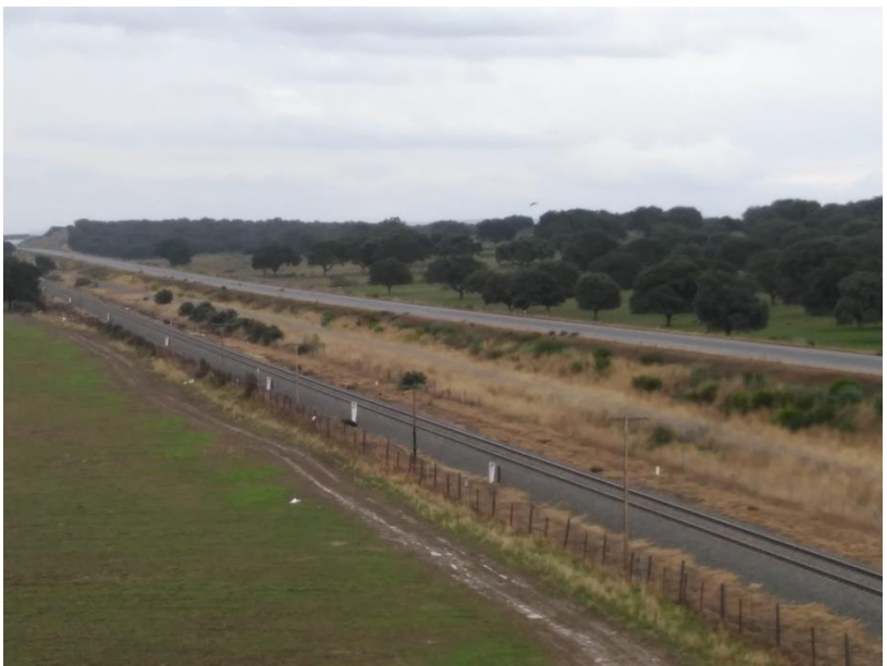
Foto 9: Espacio entre vías, coincidente con la ZEC, donde se va a construir la conexión ferroviaria, carente de vegetación de interés y delimitada por el cerramiento de las líneas de ferrocarril existentes. Al fondo puede observarse una grulla en vuelo
