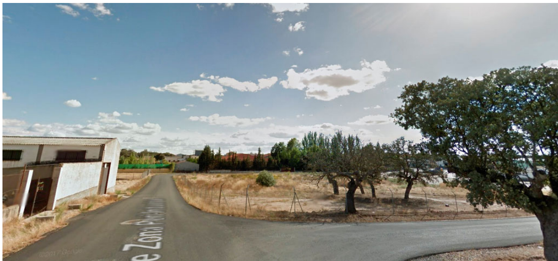
Vista 1 con nave próxima a la izquierda
