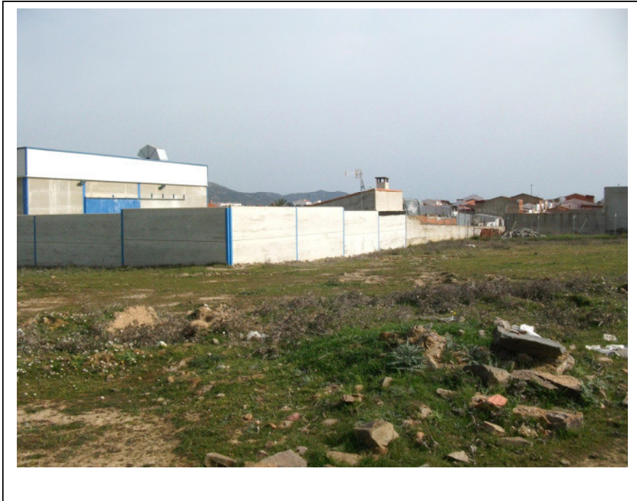
FOTO 22. Trasera de nave de empresa dedicada a taller de chapa y pintura.
