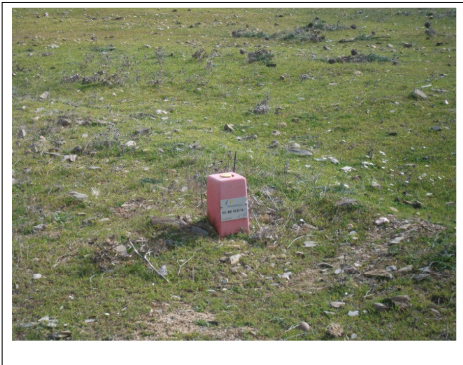
FOTO 10. Hito de cruce de línea eléctrica subterránea
