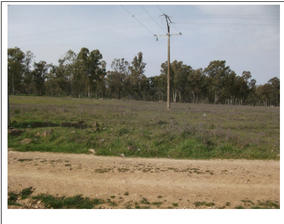
FOTO 26. Un de las líneas eléctricas de M.T. que atraviesan la futura zona industrial, que será necesario ordenar y soterrar.
