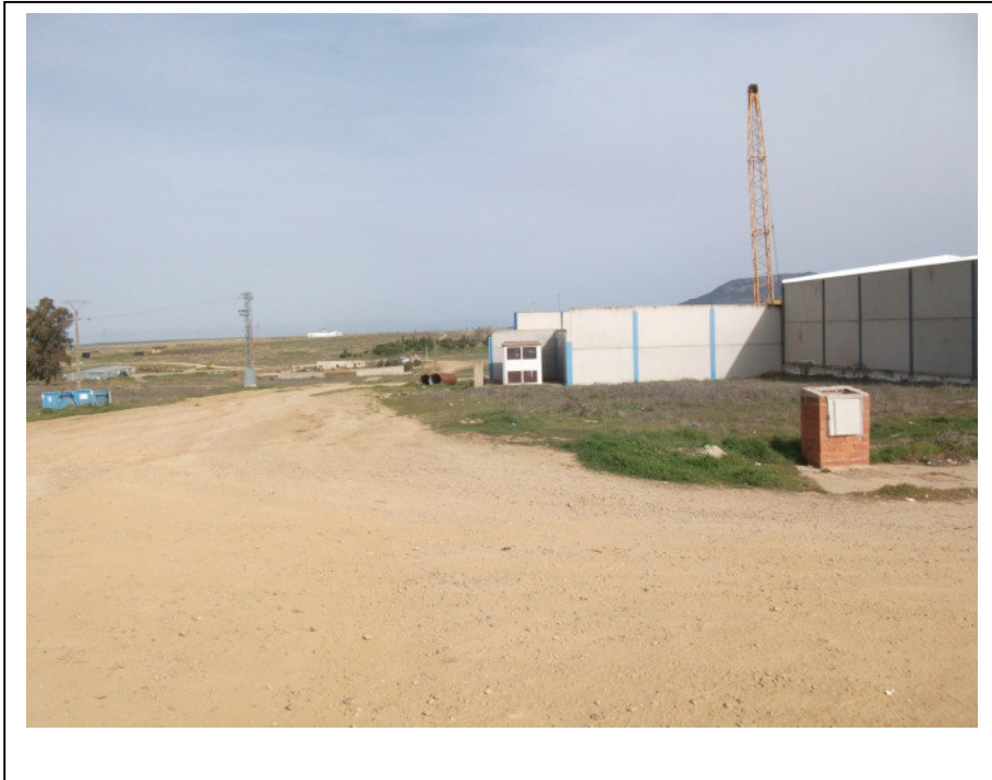
FOTO 4. Vista de la zona de modificación junto a las naves de la fase de polígono anteriormente construida.
