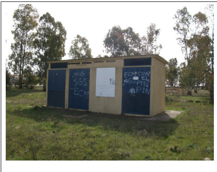
FOTO 16. Transformador existente junto a tanatorio ubicado en esta zona del P.I.
