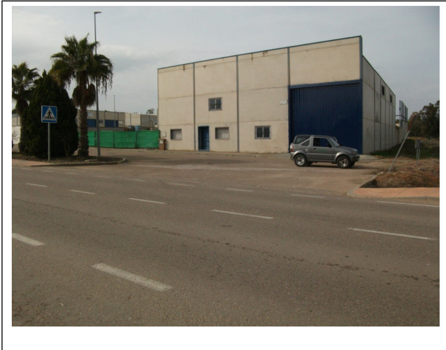
FOTO 30. Tomada desde C/ Donoso Cortés hacia la entrada norte del polígono (fase ya construida).
