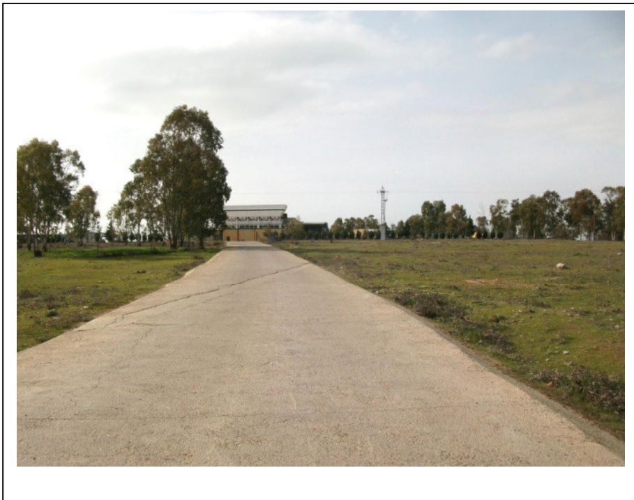
FOTO 8. Camino hormigonado de acceso a planta de fabricación de hormigones existente.
