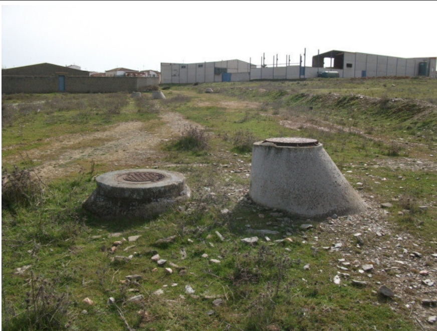
FOTO 28. Arquetas de saneamiento en el límite norte de la zona de modificación.
