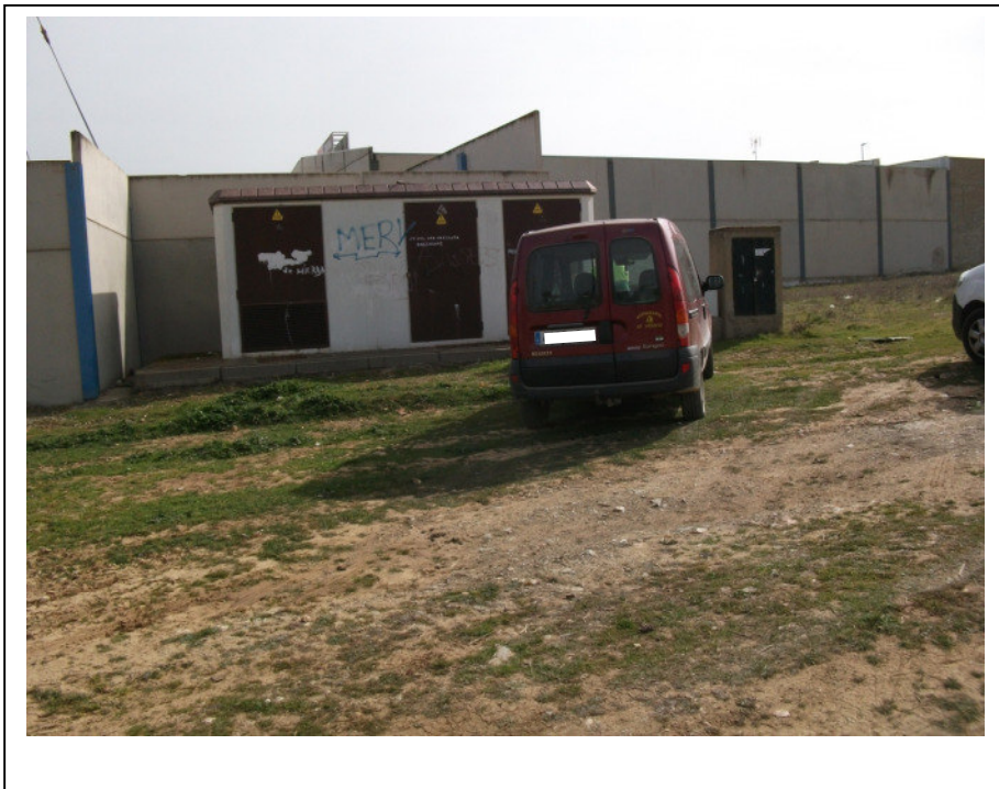
FOTO 24. Otro de los centros de transformación existente de la fase urbanizada anterior.
