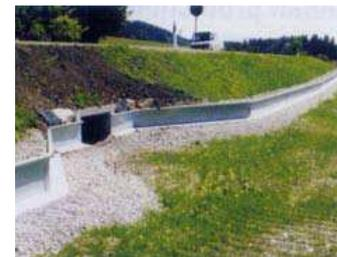
En tramos largos, la distancia máxima entre pasos será de 60 m con cerramientos-guía en paralelo a la carretera. Si el cerramiento-guía tiene forma de embudo hacia los pasos, éstos pueden instalarse cada 100 m en el entorno de las masas de agua.
