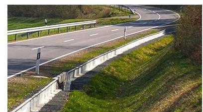
Colocada en la base del terraplén y en la cima del talud de la carretera, se instalarán asociadas a los pasos para anfibios y pasos de agua, en 100 m a cada lado del paso de anfibio o de la masa de agua junto a la carretera.
