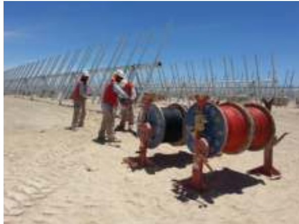
Imagen 8. Tendido de Cables Eléctricos
