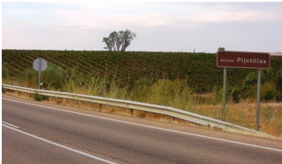
Ilustración 2.- Carretera EX-300 sobre arroyo Hediondo (también denominado arroyo Pijotillas)
