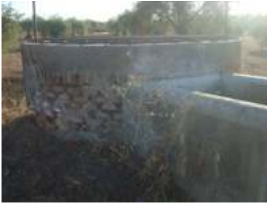
Unión de pozo y abrevadero
