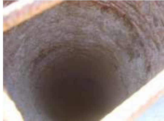
Interior de pozo
