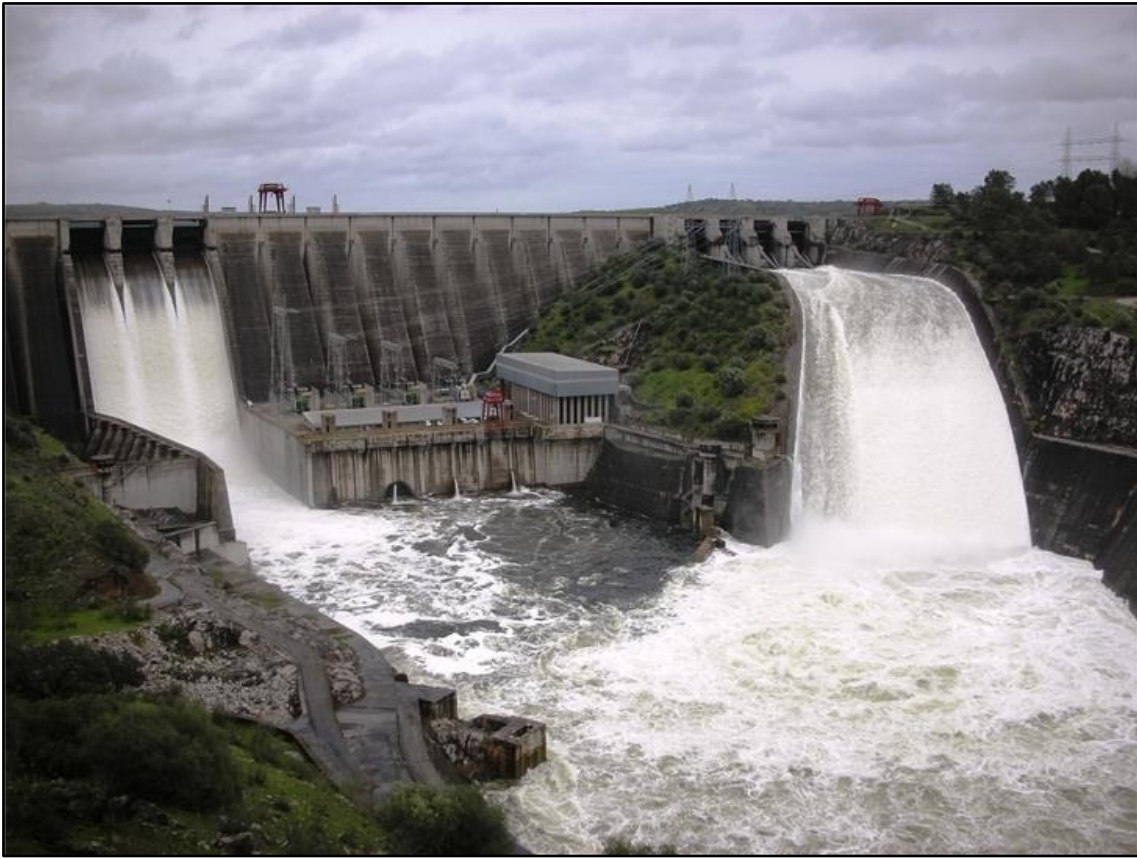
Figura 50. Central hidroeléctrica de Alcántara.
