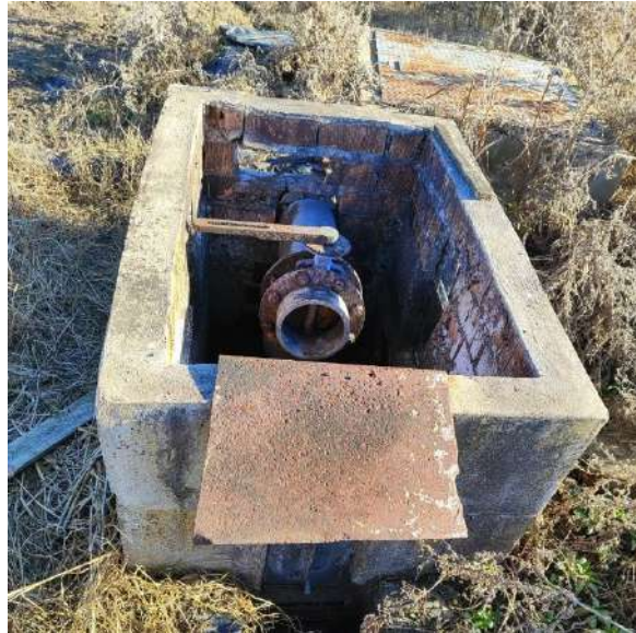
Imagen 3. Estado actual del hidrante
