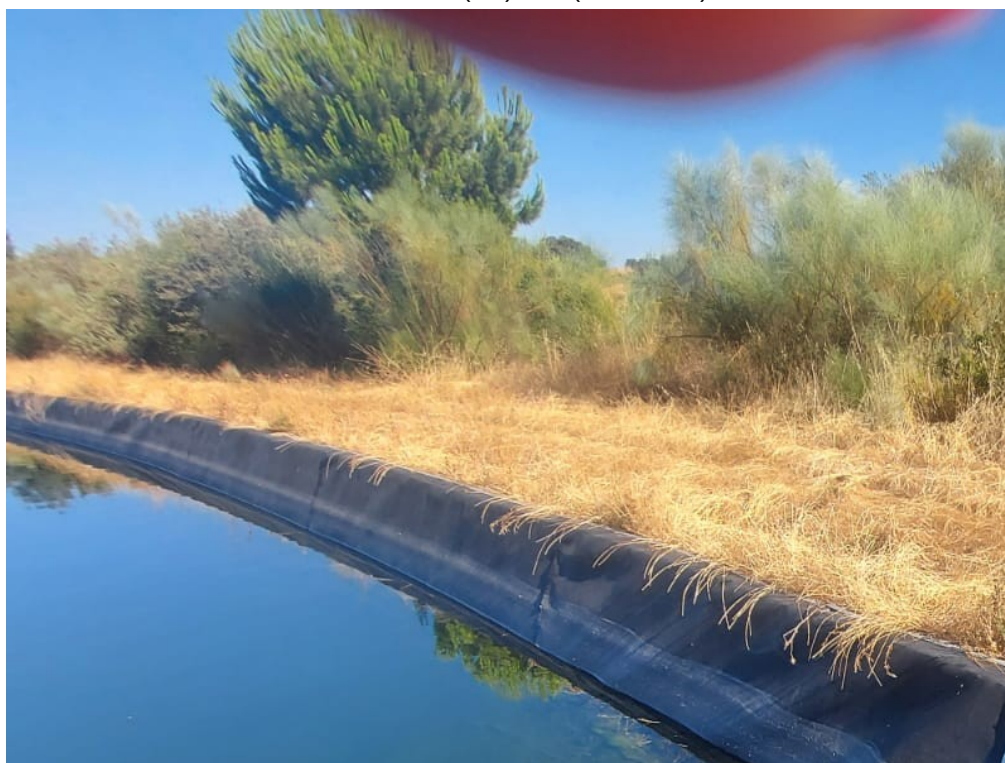
Foto. Detalle toma compuerta plana en Canal de las Dehesas.
