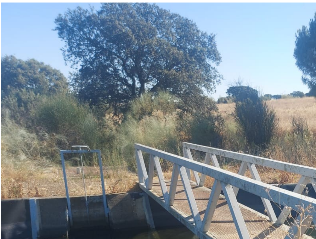
Foto. Detalle pasarela en Canal de las Dehesas
