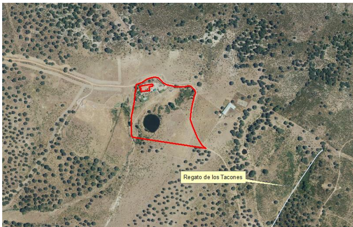
Ilustración 16. Hidrología próxima a la zona de actuación.
