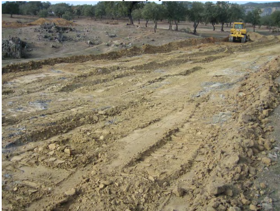
Figura 13: Retirada de tierra vegetal sobre el frente experimental número 2
