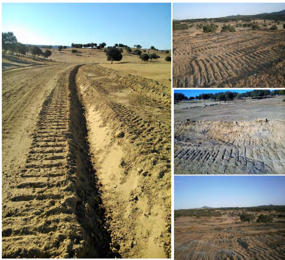
Fig 2. Diferentes vistas de la realización de los caminos auxiliares y sus cunetas.
