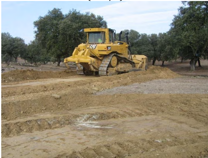
Figura 6: Movimientos de tierra realizados por el bulldozer para la apertura del camino.
