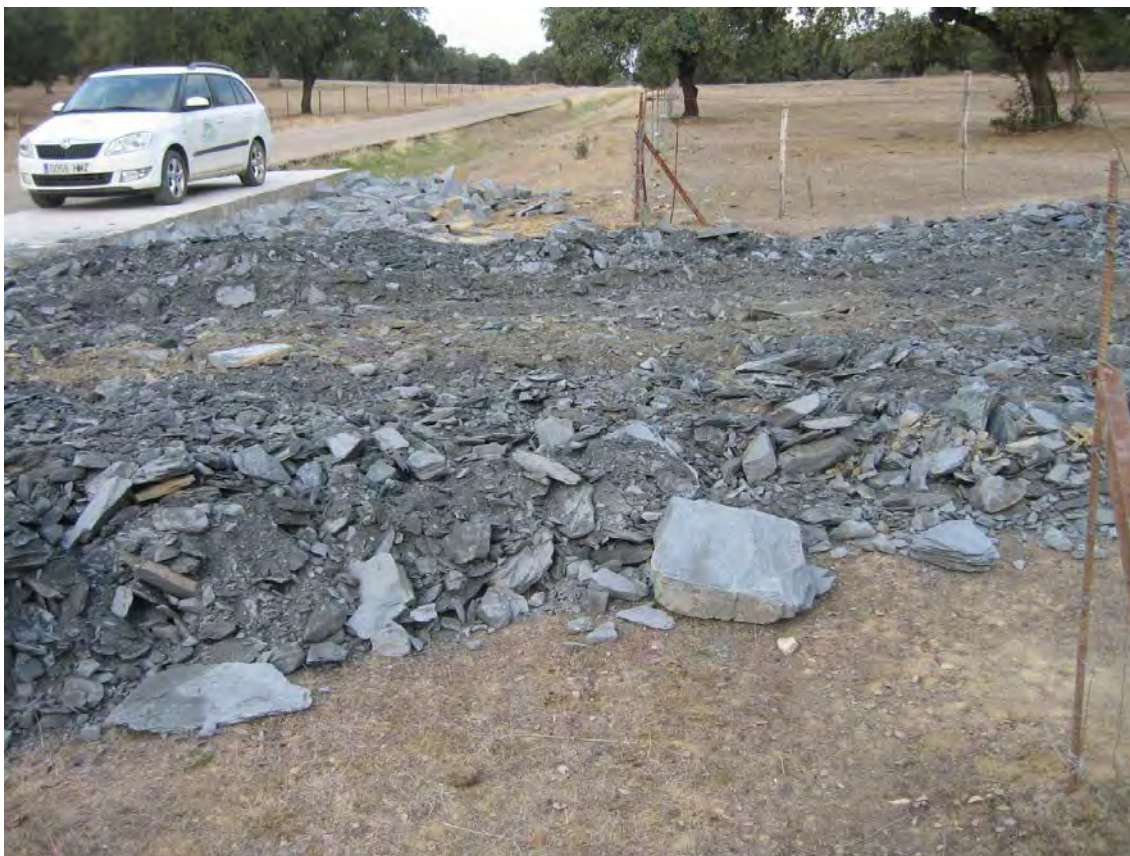
Figura 5: Plataforma de hormigón y escombros que salvan el desnivel entre la pista asfaltada y el terreno natural donde inicia el camino.
