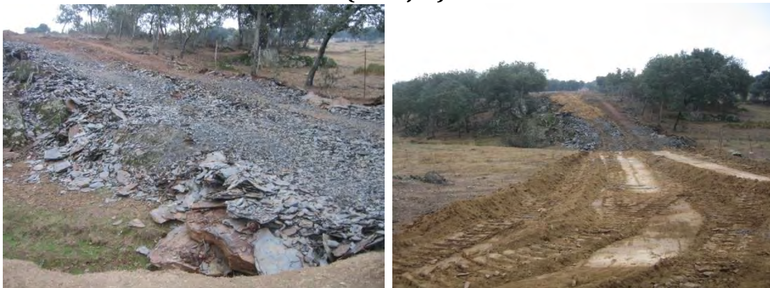
Figuras 11 y 12: Escombros de pizarra que salvan el desnivel del nuevo camino a su paso por el cauce de un arroyo seco.
