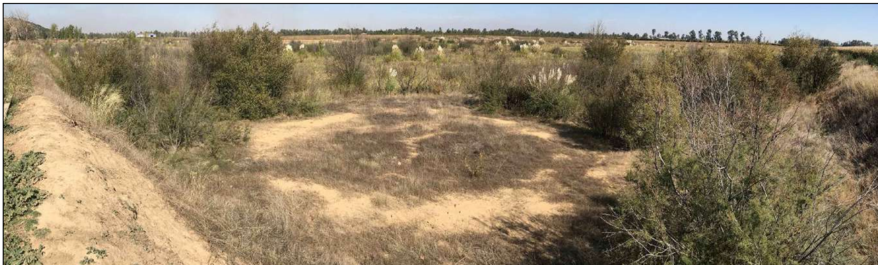
FOTO Nº 2: ZONA RESTAURADA ANTERIORMENTE. ACONDICIONAMIENTO TOPOGRÁFICO, EXTENDIDO DE TIERRA VEGETAL Y TALUDES REPERFILADOS.
