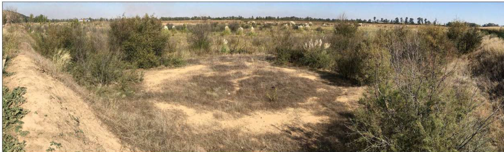
FOTO N° 2: ZONA RESTAURADA ANTERIORMENTE. ACONDICIONAMIENTO TOPOGRÁFICO, EXTENDIDO DE TIERRA VEGETAL Y TALUDES REPERFILADOS.
