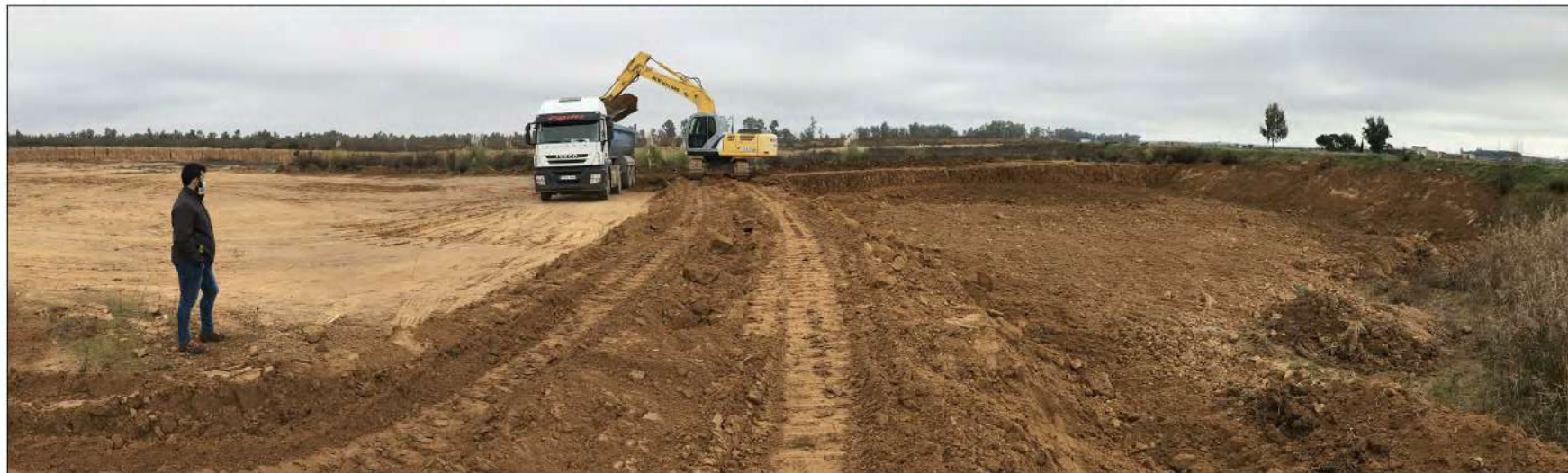
FOTO N° 1: EXPLOTACIÓN ACTUAL. DESMONTE DE T.V. Y EXTRACCIÓN POR ENCIMA DEL N.F. EN AGUAS ALTAS. A LA DERECHA, TALUD FINAL REPERFILADO Y CABALLÓN DE T.V.
