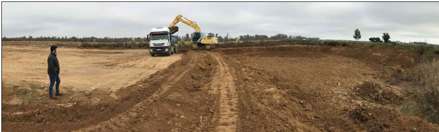
FOTO Nº 1: EXPLOTACIÓN ACTUAL. DESMONTE DE T.V. Y EXTRACCIÓN POR ENCIMA DEL N.F. EN AGUAS ALTAS. A LA DERECHA, TALUD FINAL REPERFILADO Y CABALLÓN DE T.V.
