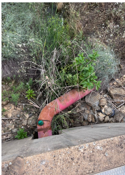
Salida de tubería de 315mm
