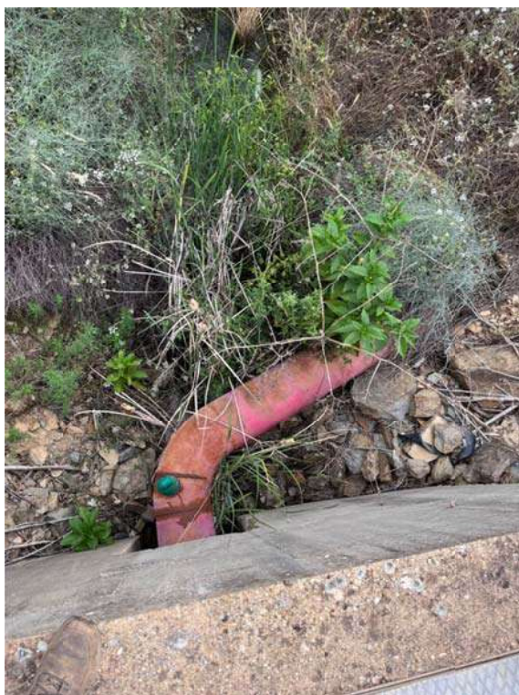
Salida de tubería de 315mm
