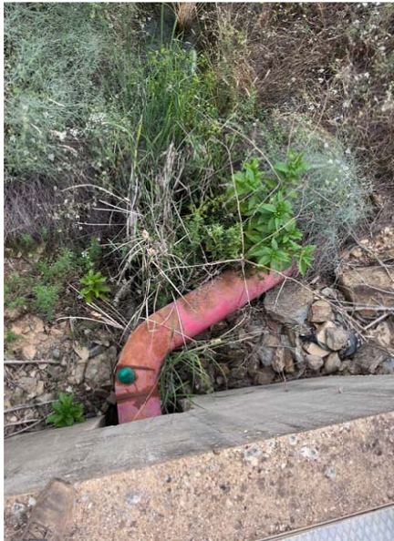
Salida de tubería de 315mm
