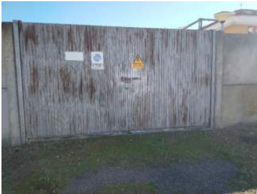
Subestación "VEGAS BAJAS" 20kV punto donde finaliza la prospección.
