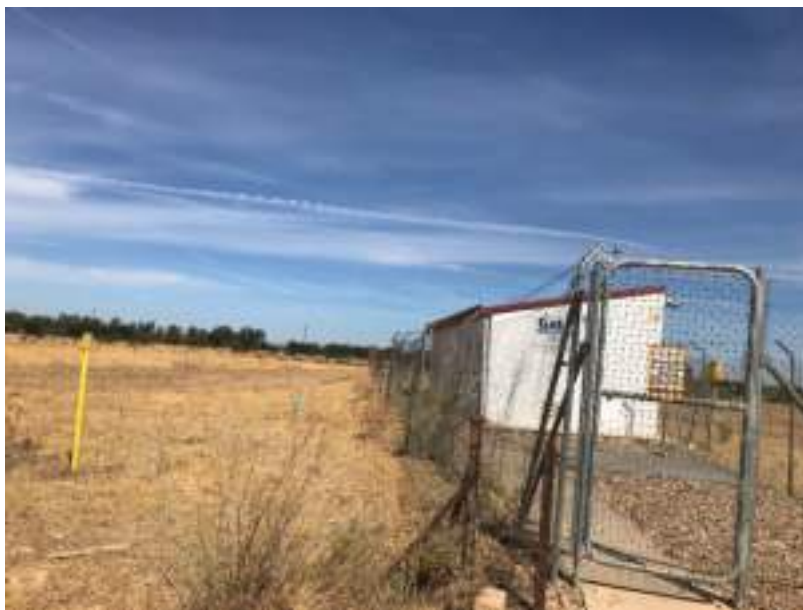
Ilustración 48.- Zona de cruce de la evacuación con uno de los gasoductos. Fuente: Innogestión Ambiental.
