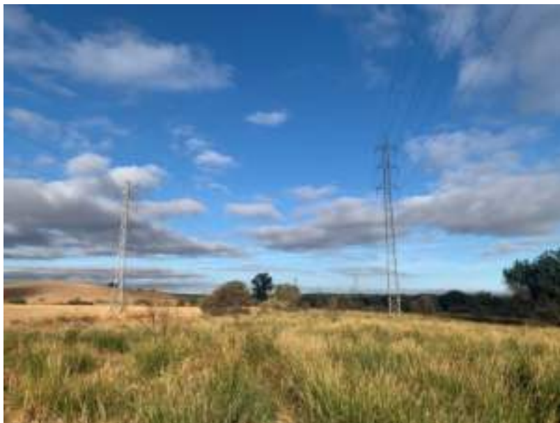
Ilustración 89.- Líneas eléctricas propiedad de REE. Fuente: Innogestión Ambiental.
