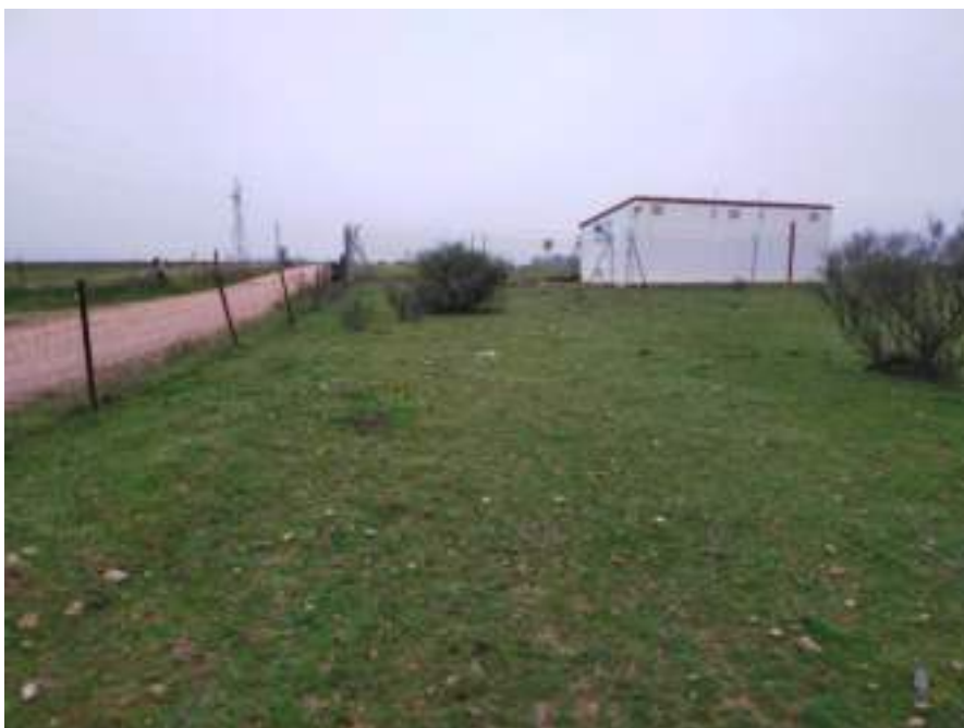
Caseta del gasoducto.
