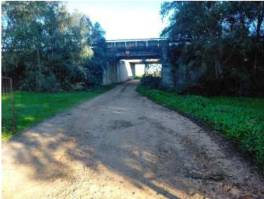
Puente de la A-5.
