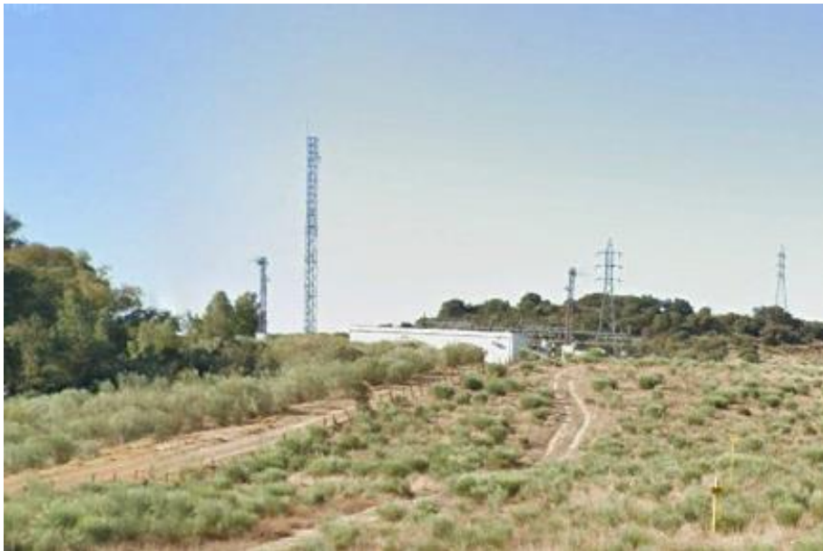
Ilustración 22.- Subestación SET Cerro Gordo 20 kV.
