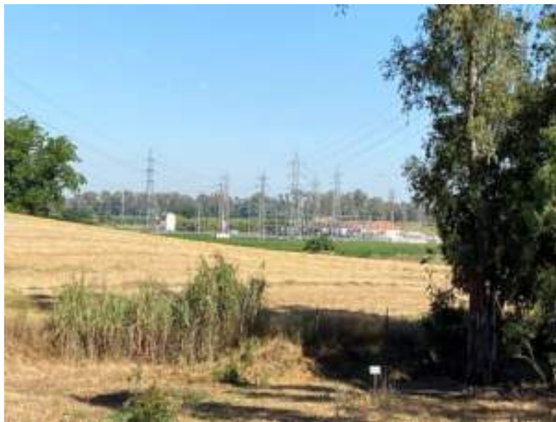
Ilustración 20.- Subestación SET Badajoz 20 kV.
