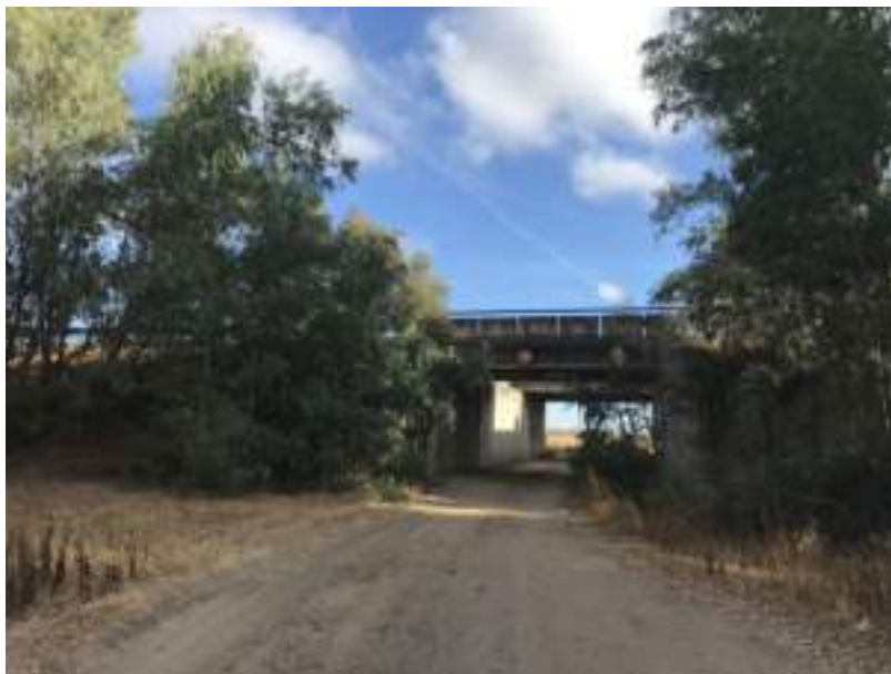
Ilustración 16.- Zona de cruce de línea subterránea de evacuación conjunta de “PSFV San Telmo” y “PSF Atalaya” con arroyo de Los Rostros. Fuente: Innogestión Ambiental
