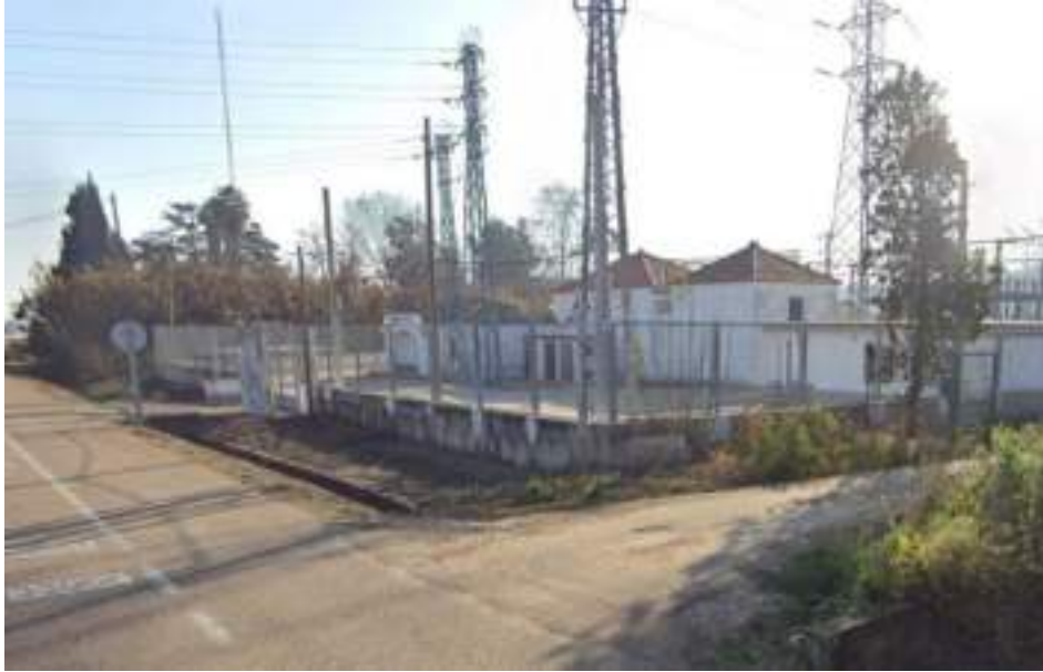
Ilustración 21.- Subestación SET Badajoz 20 kV.
