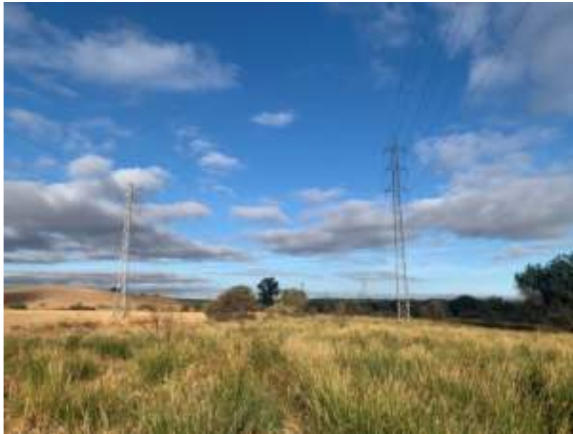
Ilustración 47.- Líneas eléctricas propiedad de REE. Fuente: Innogestión Ambiental.
