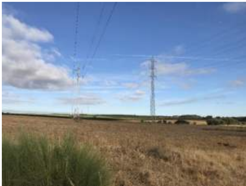
Ilustración 10.- Presencia en el entorno de otras líneas eléctricas existentes.
