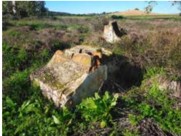
Restos de la pasarela sobre el arroyo de Los Rostros.
