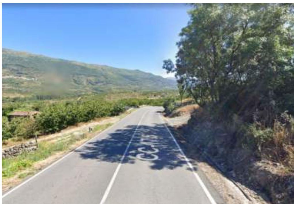
Figura 24: Cruce Nº5 CC02: Carretera CC - 233
