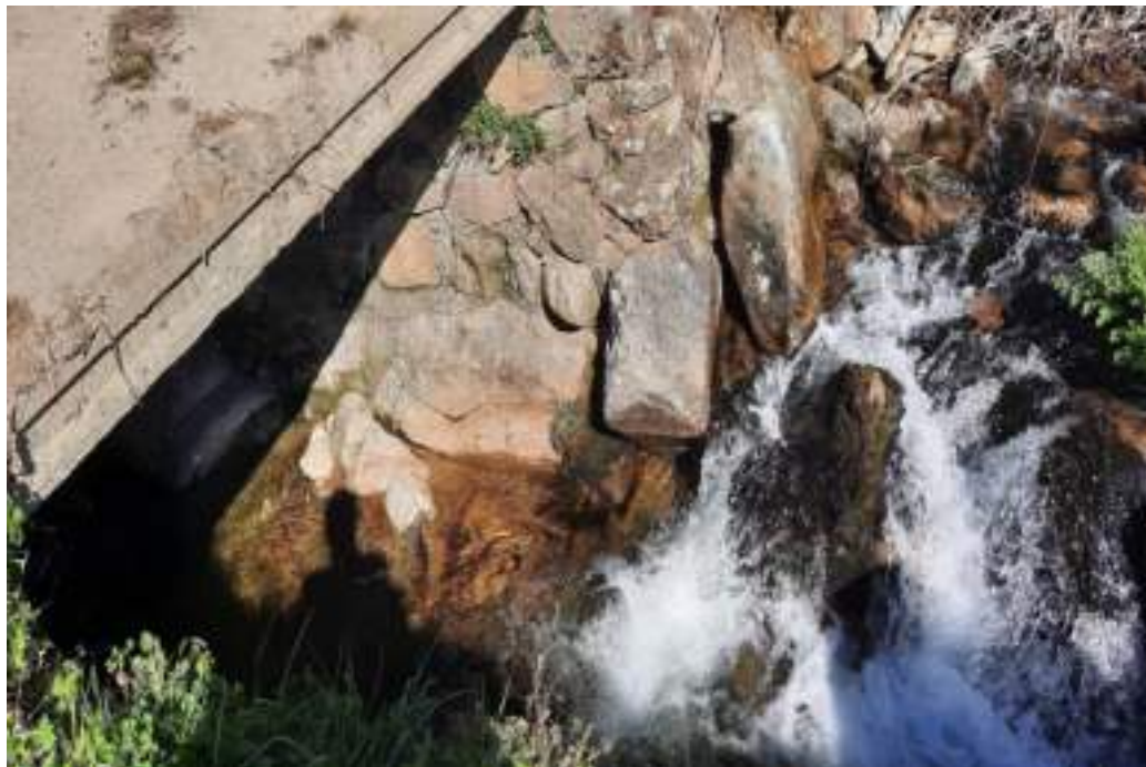
Figura 17: Cruce Nº CHT1: Cruce sobre la Garganta Marta
