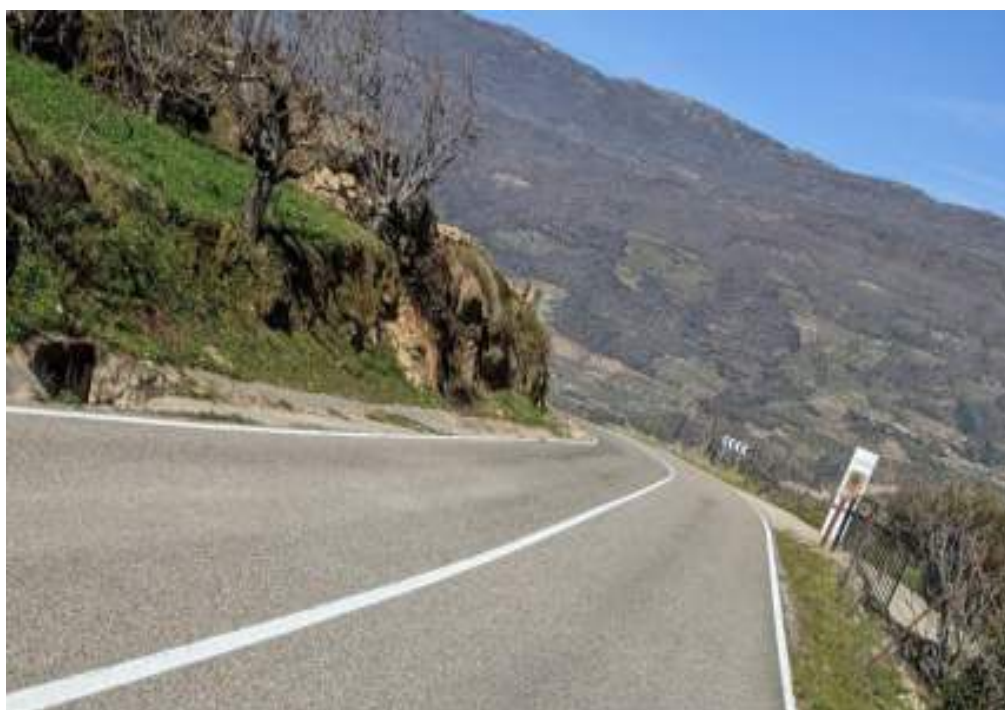
Figura 25: Cruce Nº CC12: Carretera CC-233
