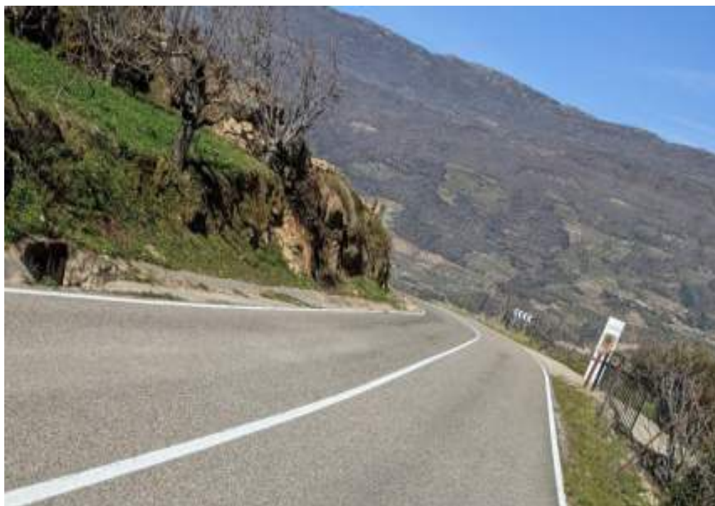
Figura 25: Cruce Nº CC12: Carretera CC-233
