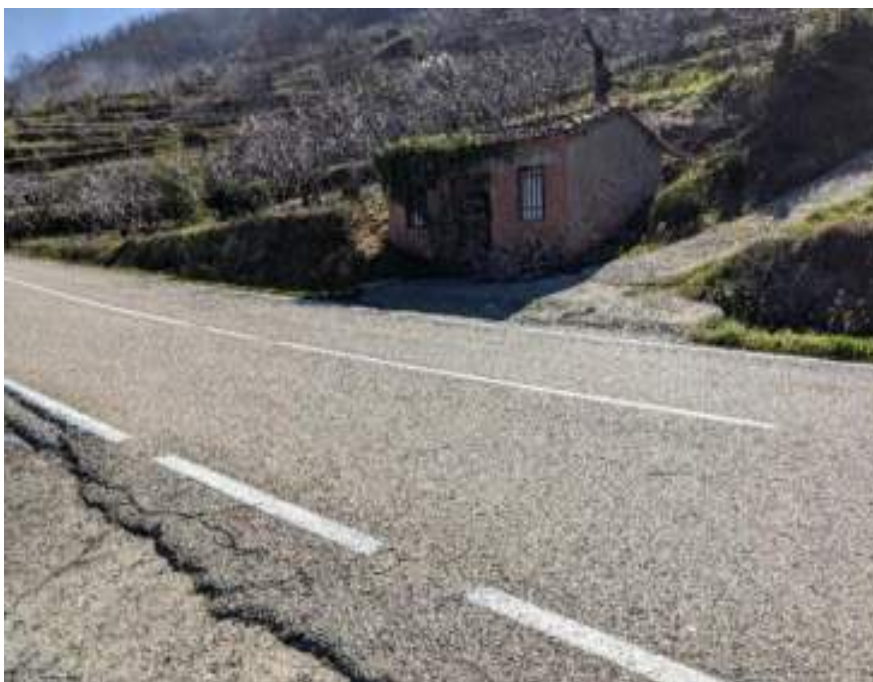
Figura 26: Cruce Nº3 CC15: Carretera CC-233
