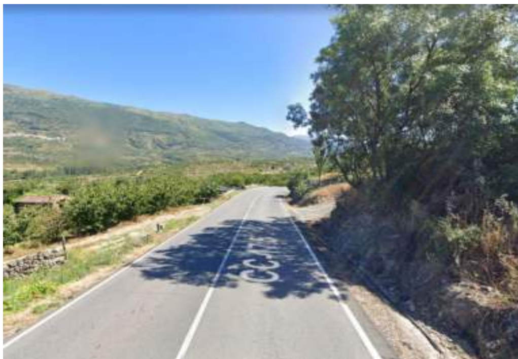
Figura 24: Cruce Nº5 CC02: Carretera CC - 233
