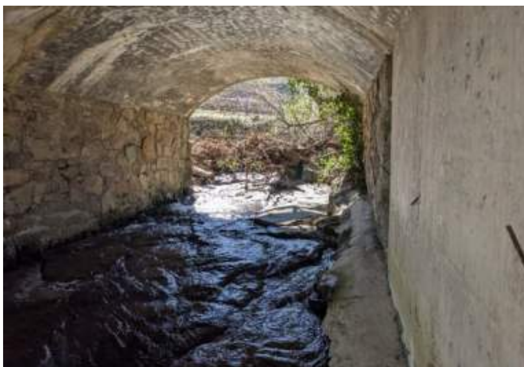
Figura 22: Cruce Nº CHT6: paso bajo el puente de la Garganta Bonal
