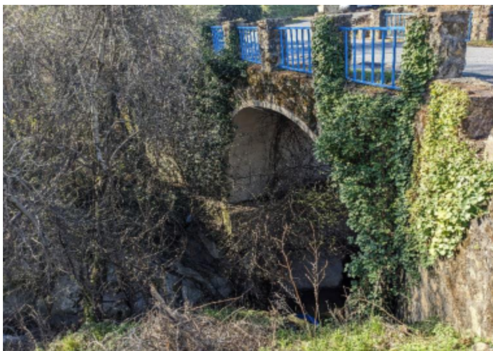
Figura 20: Cruce Nº CHT4: Puente sobre la Garganta Bonal
