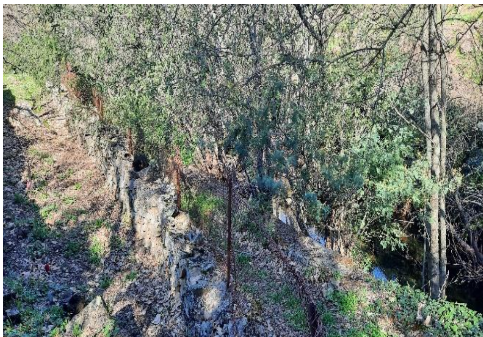
Figura 19: Cruce Nº CHT3: Paso aéreo de la red de riego y llenado de Las Rozas por la Garganta Bonal
