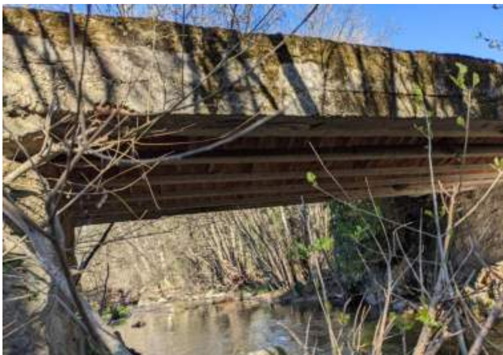
Figura 21: Cruce Nº CHT5: Puente sobre la Garganta Bonal
