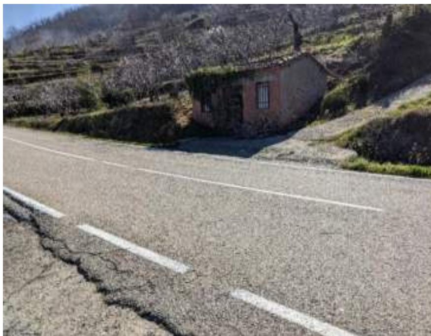
Figura 26: Cruce Nº3 CC15: Carretera CC-233
