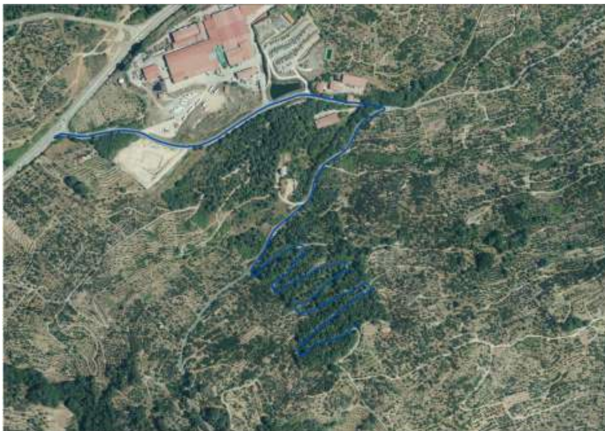
Figura 9: Camino de acceso de la Balsa Las Rozas
