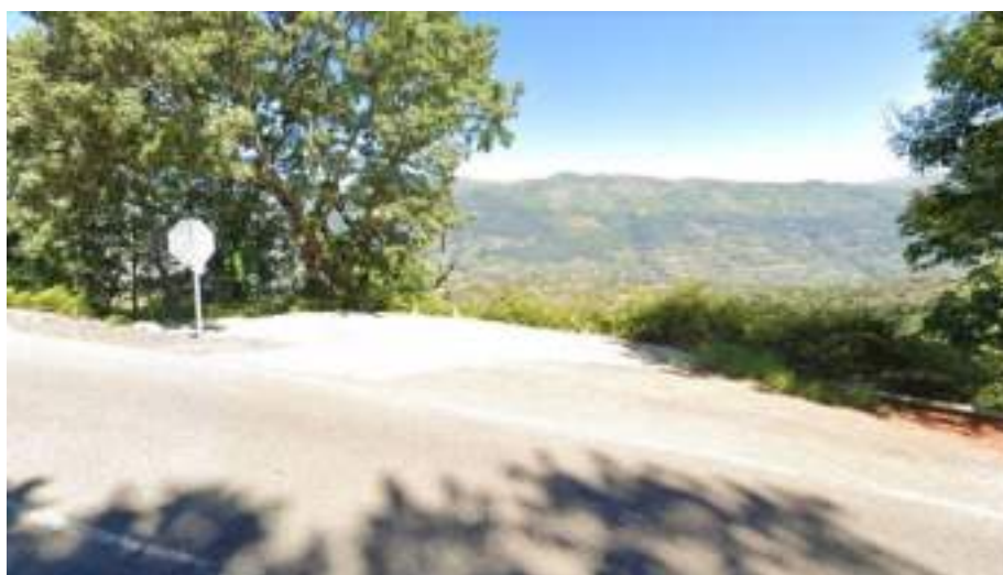
Figura 7: Entrada del camino hacia La Balsa Las Pedrosas
