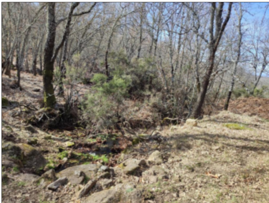
Figura 25: Ubicación desagüe balsa
