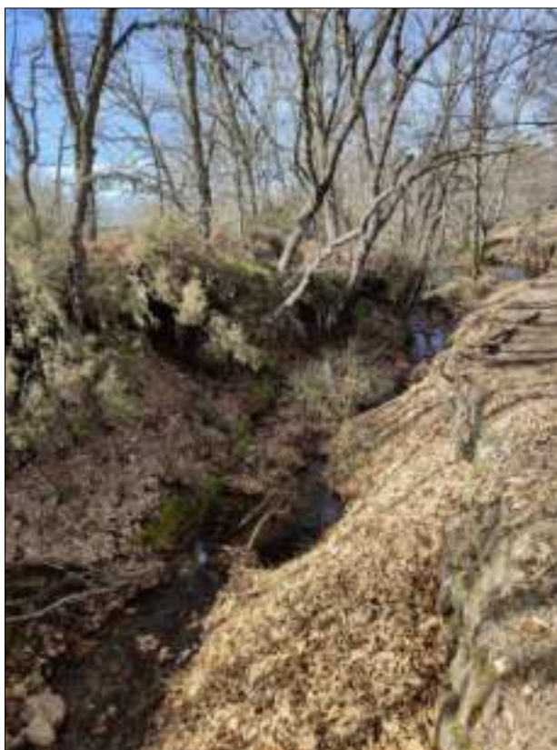
Figura 26: Arroyo innominado aguas abajo actuaciones planteadas.
