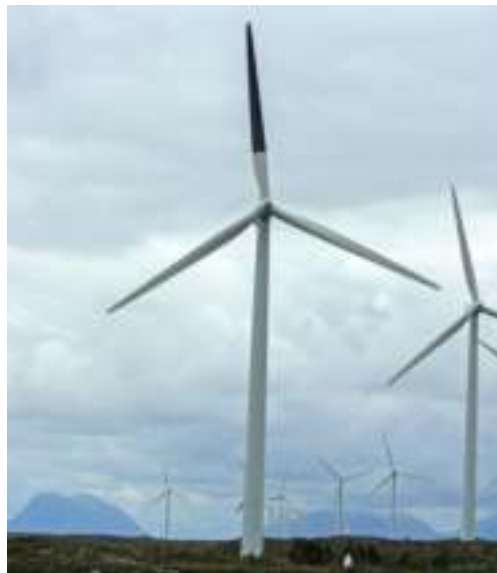
Ilustración 100. Turbina con una pala pintada en el parque eólico de Smøla. Foto de May et al. 2020.
