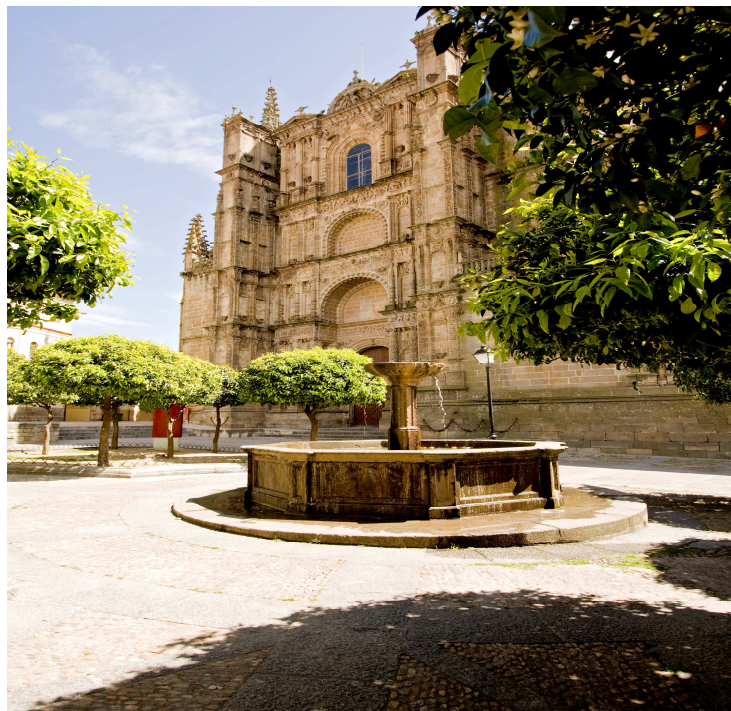
Fotografía n° 25.- Catedral de Plasencia
