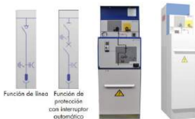
Ilustración 14: Celdas modulares de MT
