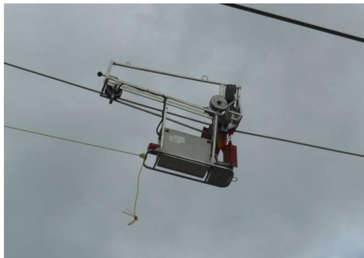
Vista de la máquina semiautomática de instalación.
