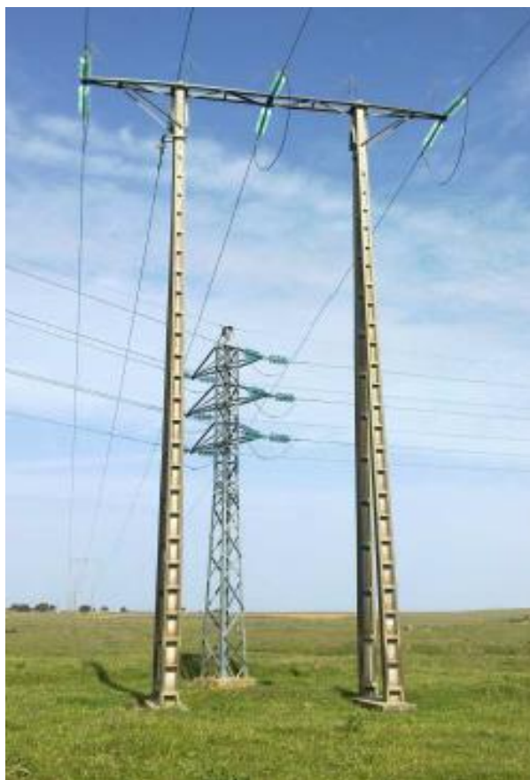
Figura 3. Tipo de apoyo a desmontar
