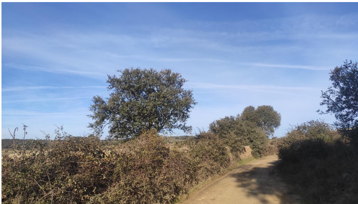
Fotografía 43. Cruce aéreo de la línea por la Vereda de Jerez de los Caballeros, entre los apoyos 02 y 03.
