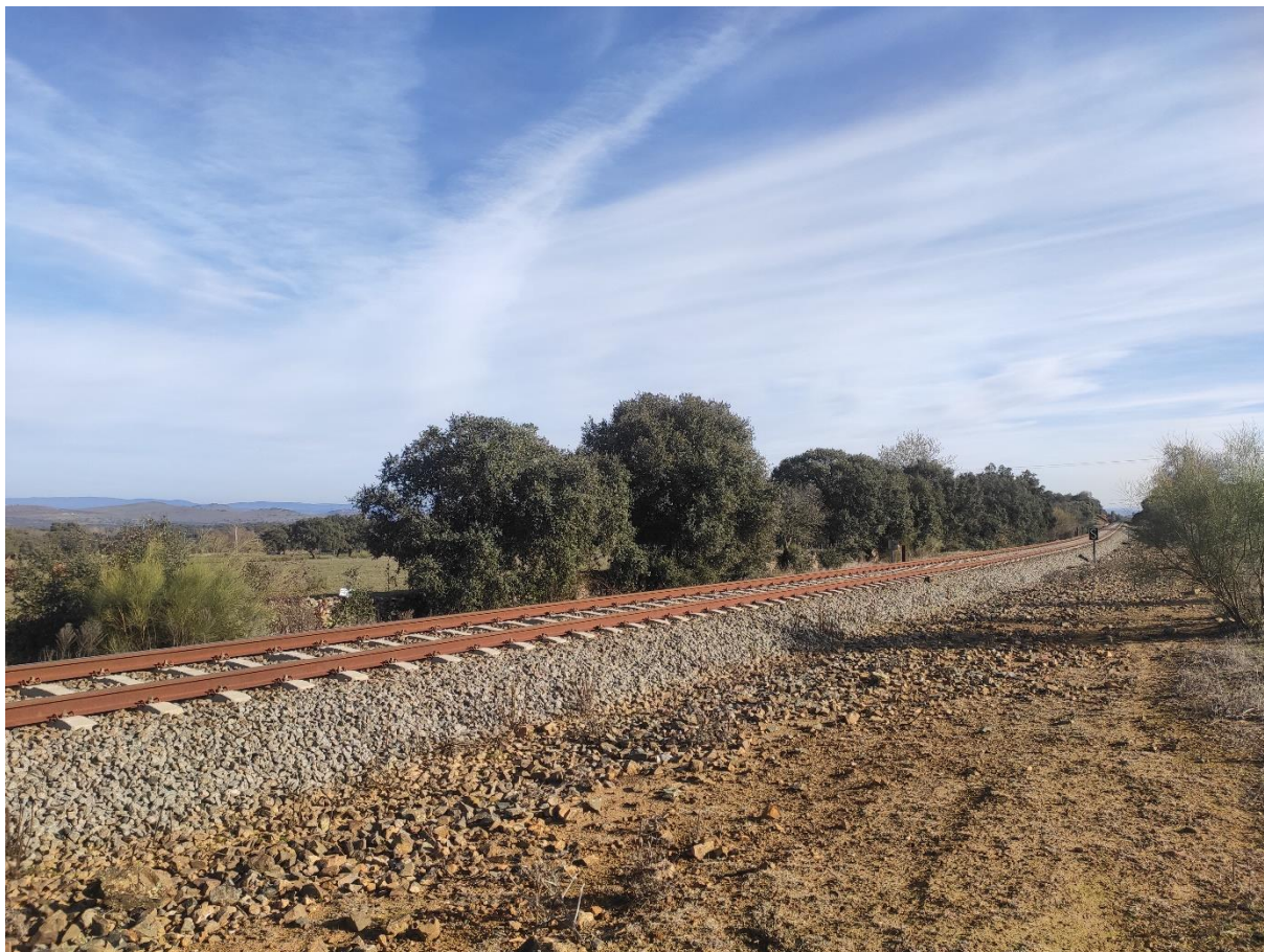
Fotografía 72. Cruzamiento aéreo de la línea de evacuación entre los apoyos 12 y 13 con vía de ferrocarril Zafra-Huelva.
