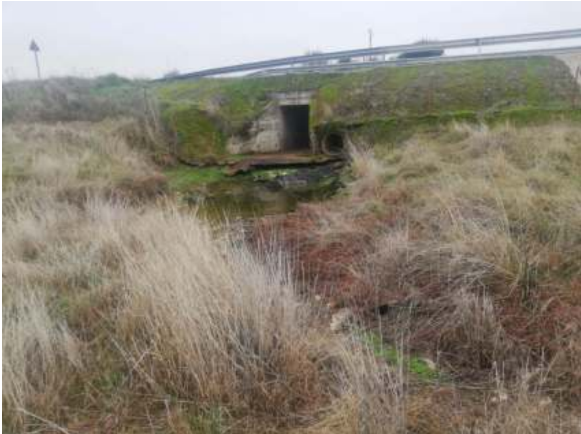
Vegetación densa en torno a un pequeño regato que atraviesa la línea en paralelo a la carretera
