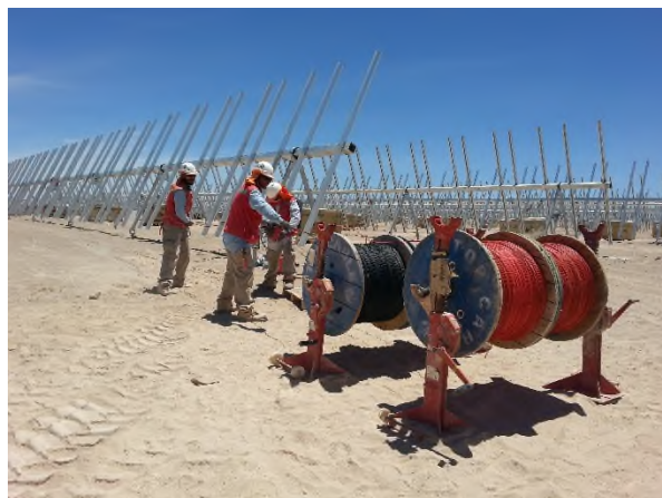
Imagen 7. Tendido de Cables Eléctricos
