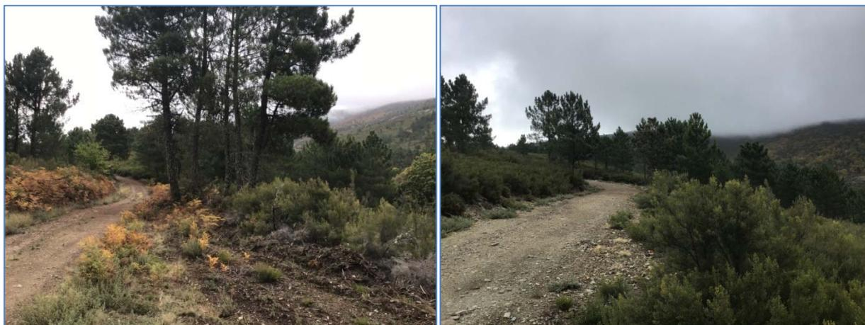
Se ha determinado que en los accesos a ejecutar el ancho de rodadura para el tránsito de maquinaria es de 5,00 metros, buscando el mínimo movimiento de tierra siempre y cuando la orografía lo permita.
