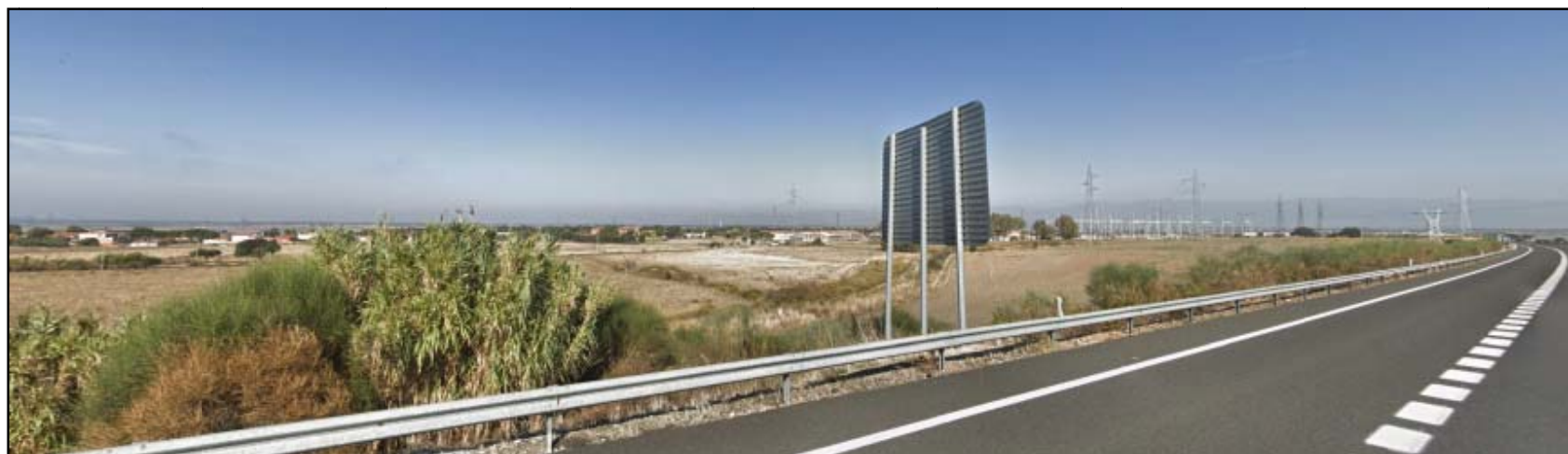
Figura 64. Desde la autovía A-5 al NE de Almaraz (P.K. 195.700, aproximadamente) la planta solar no es visible. Por el contrario, varios apoyos de la LAAT son muy visibles por su proximidad. No obstante, la presencia de la SET Almaraz y de los numerosos tendidos que a ella se dirigen reducen el impacto real de la LAAT objeto del proyecto, ya que se insertaría en una zona con abundantes apoyos de gran tamaño ya existentes.
