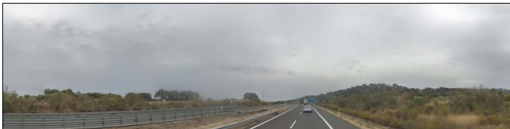
Figura 66. En cuanto a la visibilidad de la LAAT desde la A-5 al suroeste de Almaraz, su trazado cruza la autovía en esa misma zona, por lo que los dos apoyos adyacentes son lógicamente muy visibles. No obstante, como se ha comentado en la figura anterior, la autovía circula en esta zona en talud y/o con abundante vegetación en primer plano, por lo que la visibilidad real en este tramo va a ser muy fragmentaria. Por otro lado, en las inmediaciones de este punto hay al menos otros tres tendidos de alta y media tensión que cruzan la A-5, por lo que el impacto real de su construcción se ve muy atenuado.
