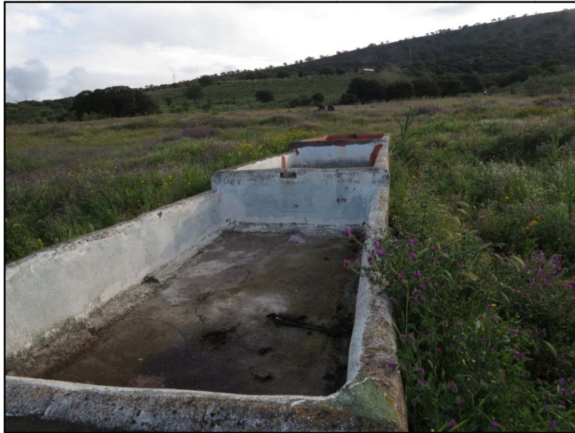
Figura 28. Abrevadero seco situado en el recinto norte de la planta.
