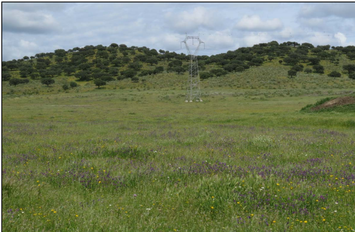
Figura 17. El Arroyo del Paradero en la zona central de la planta, aguas arriba de la balsa construida en esa zona. No se aprecia ni siquiera una mínima caja de cauce, ni ningún tipo de vegetación distintiva.
