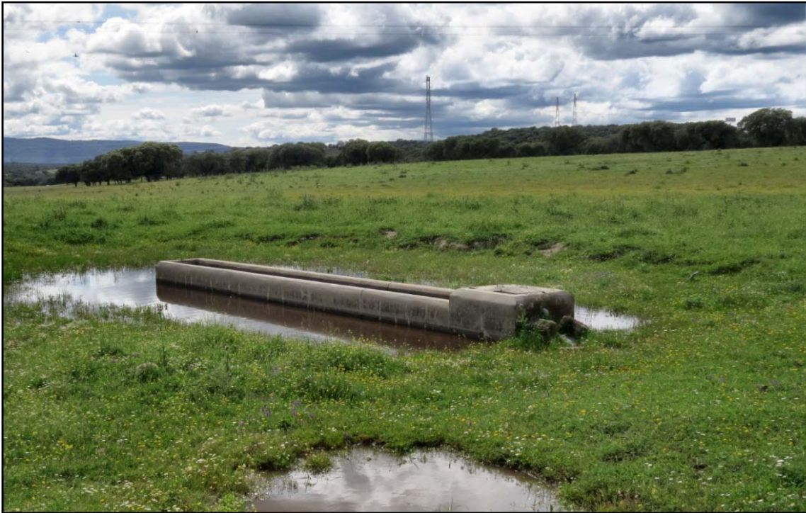
Figura 25. Abrevadero situado en la zona central de la zona de estudio, cerca del Arroyo del Paradero. Se llena mediante bombeo desde la balsa adyacente
