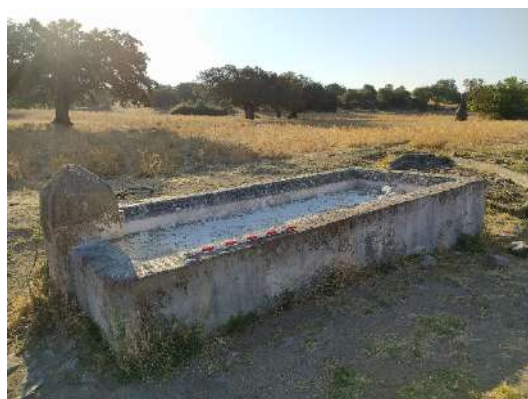
Foto general de abrevadero.
