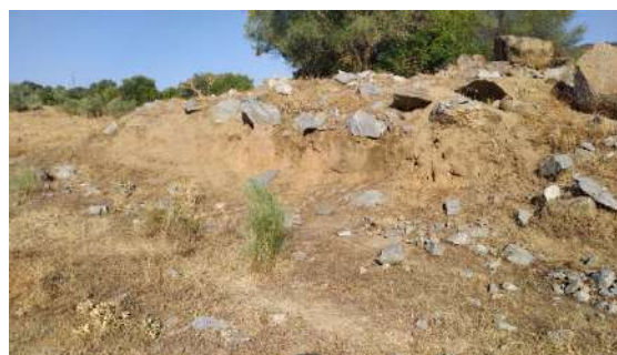
Zonas con movimientos de tierra.
