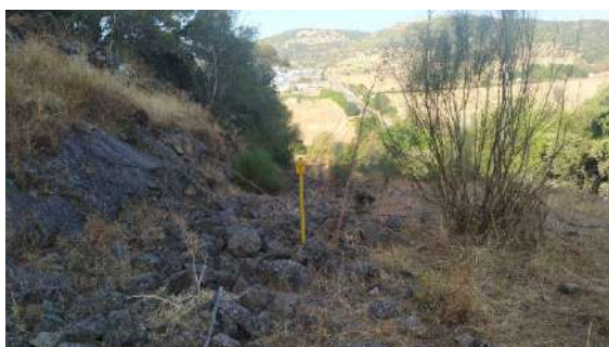
Señalización del gaseoducto.
