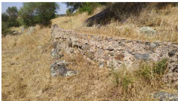
Muro de contención y canalización de aguas.
