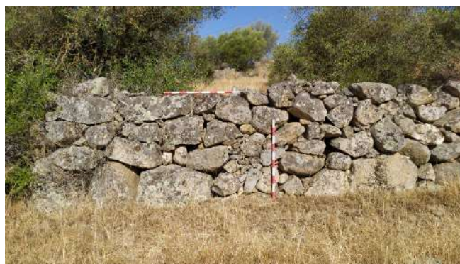
Muro lindero de grandes dimensiones.
