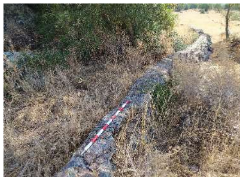
Muro de contención y canalización de aguas.
