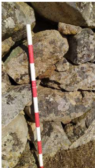
Material constructivo utilizado para calzar el muro.
