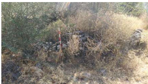
Estructuras junto a muro lindero.
