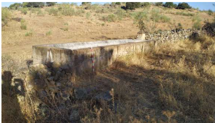
Vista general del abrevadero.
