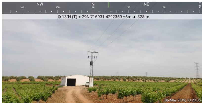
Figura 31.-Vista general de la edificación existente
