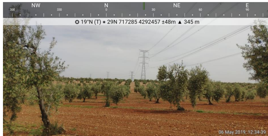
Figura 29.-Vista particular de la LAT existente
