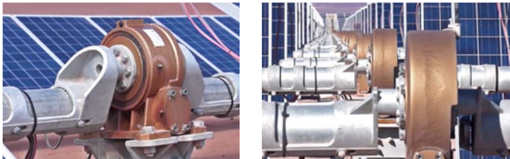
Detalle del motor del seguidor sobre los que van instalados los paneles
