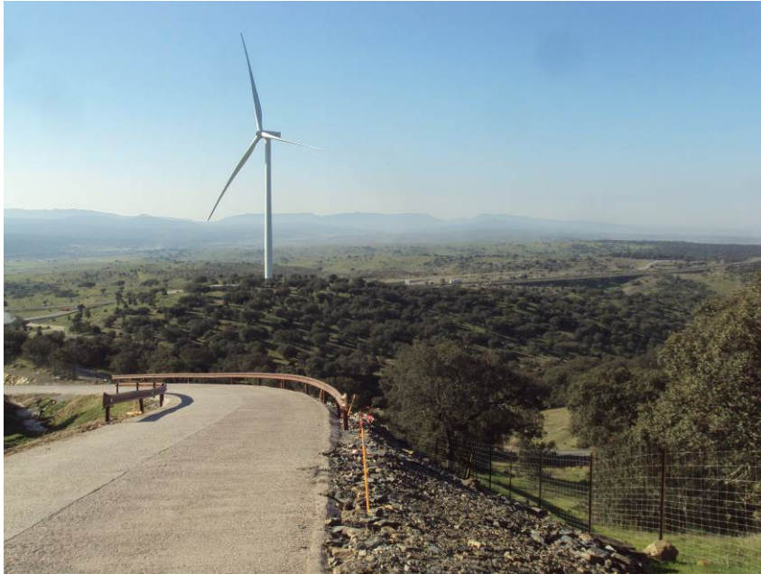
Vista al suroeste desde la zona sur del parque eólico Merengue.
