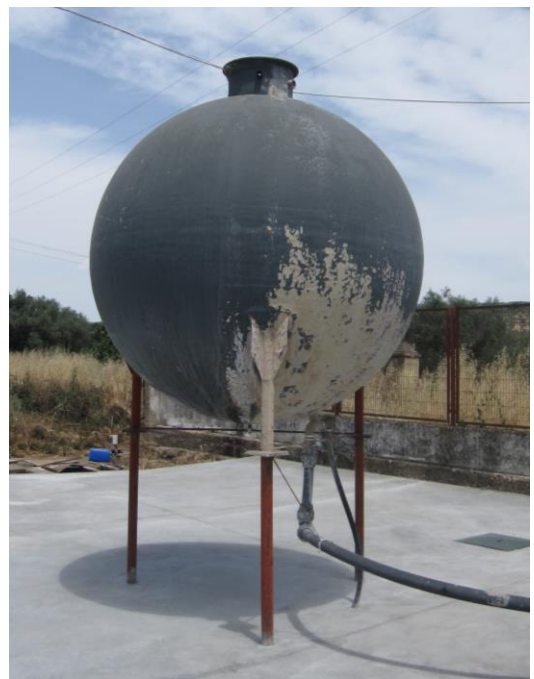
Imagen 9.1.-Depósito de acumulación 2.
