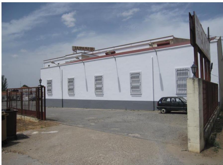
Imagen 11.-Acceso 1 a la Industria (acceso a través de la N-435).
