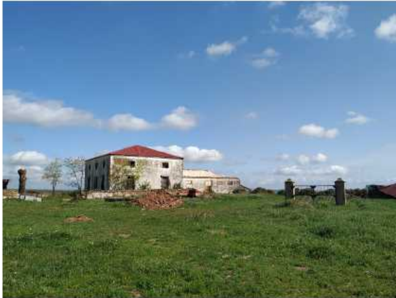
Figura 17.- Edificación existente que queda fuera de la zona de implantación de la planta fotovoltaica.
