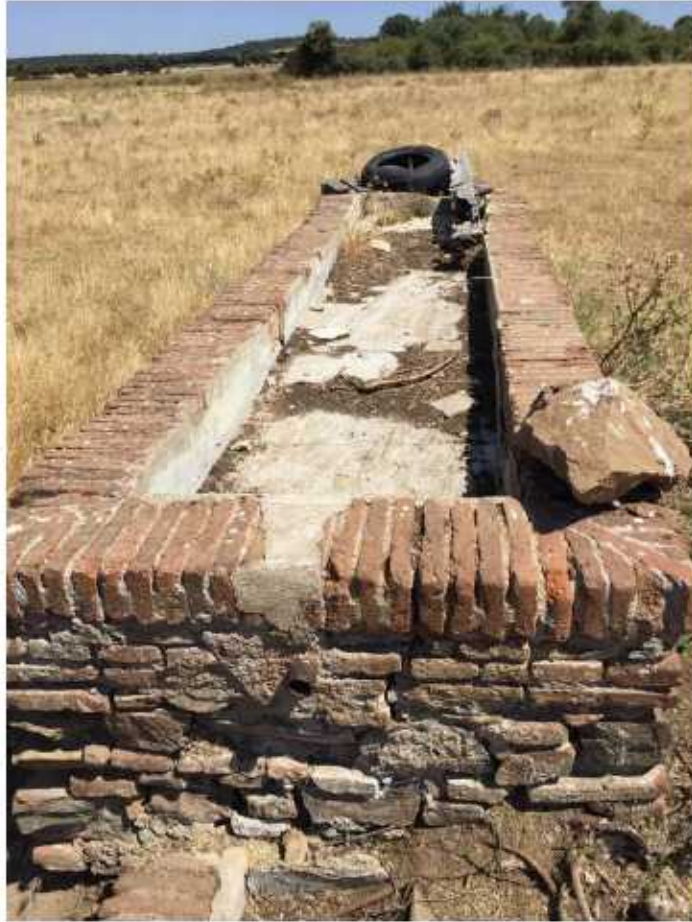
Estructura hidráulica, pileta SXVIII-SXX
