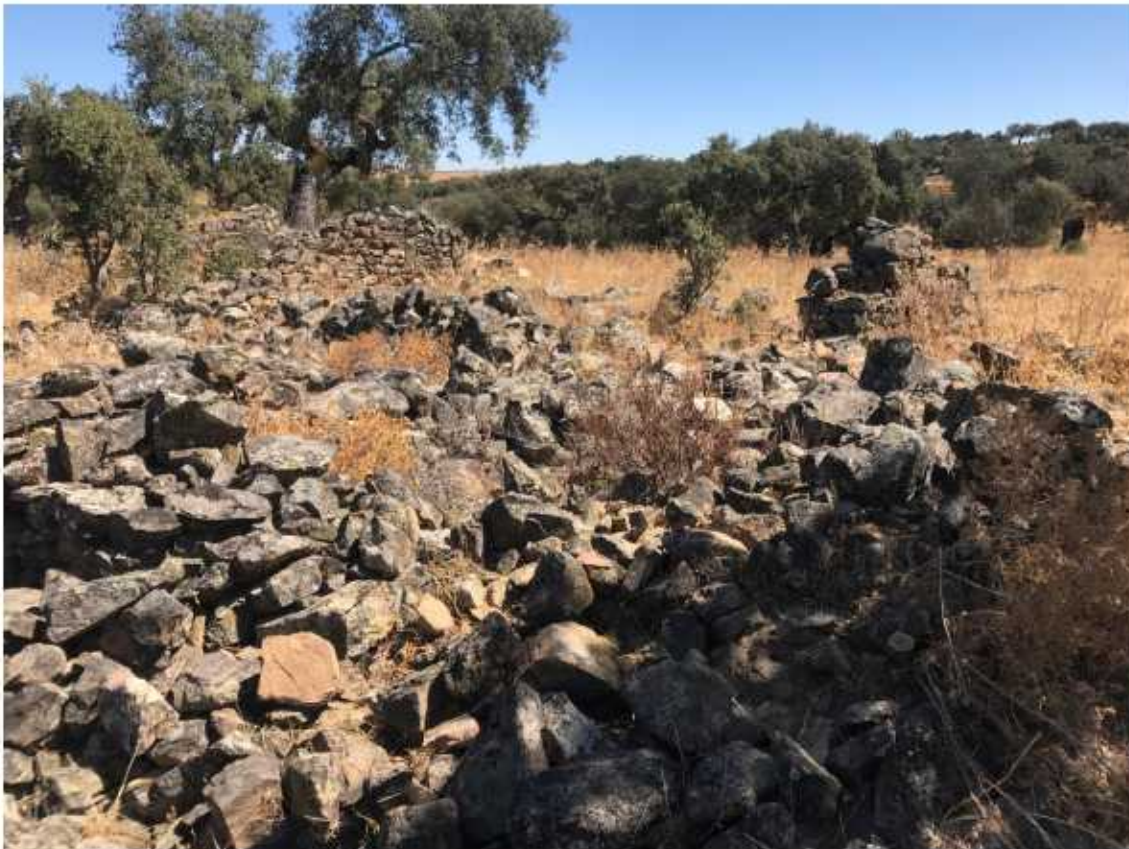
Estructuras en ruina del Complejo Agroganadero.
